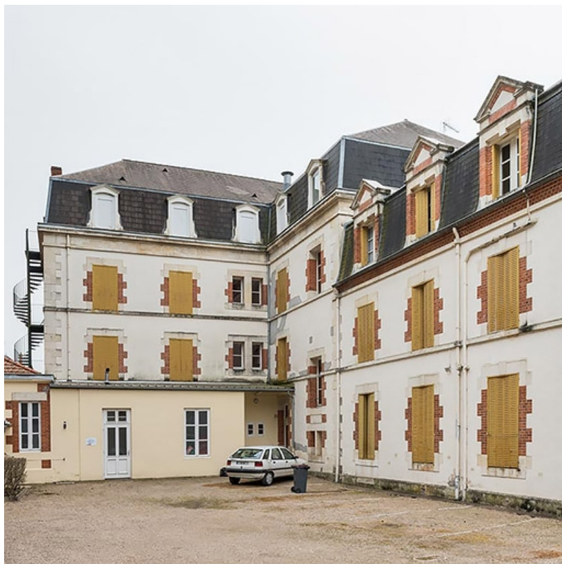
Façade sur la cour.
