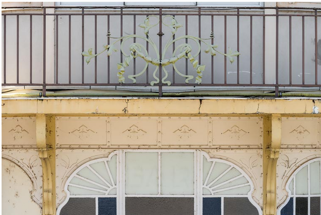
Aile ouest, salle à manger, détail.
