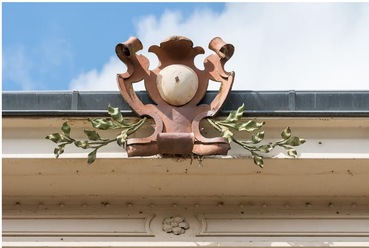
Aile ouest, salle à manger, détail.
