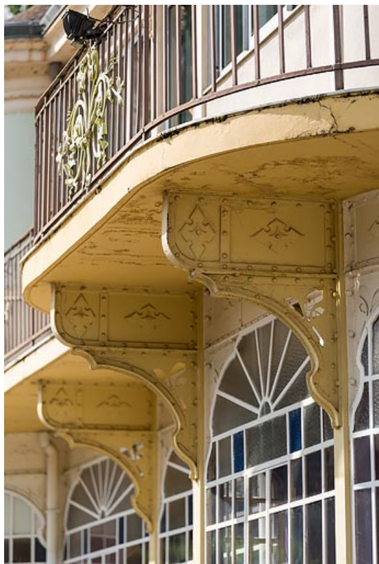
Aile ouest, salle à manger, détail.
