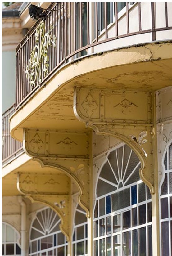
Aile ouest, salle à manger, détail.
