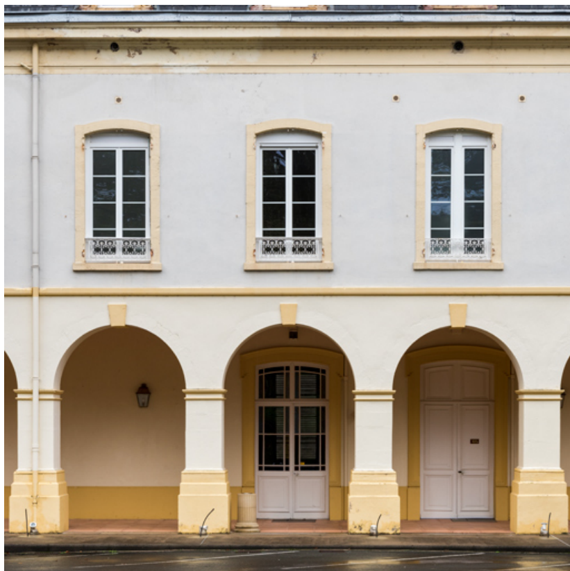
Cour, détail de l'aile nord.
