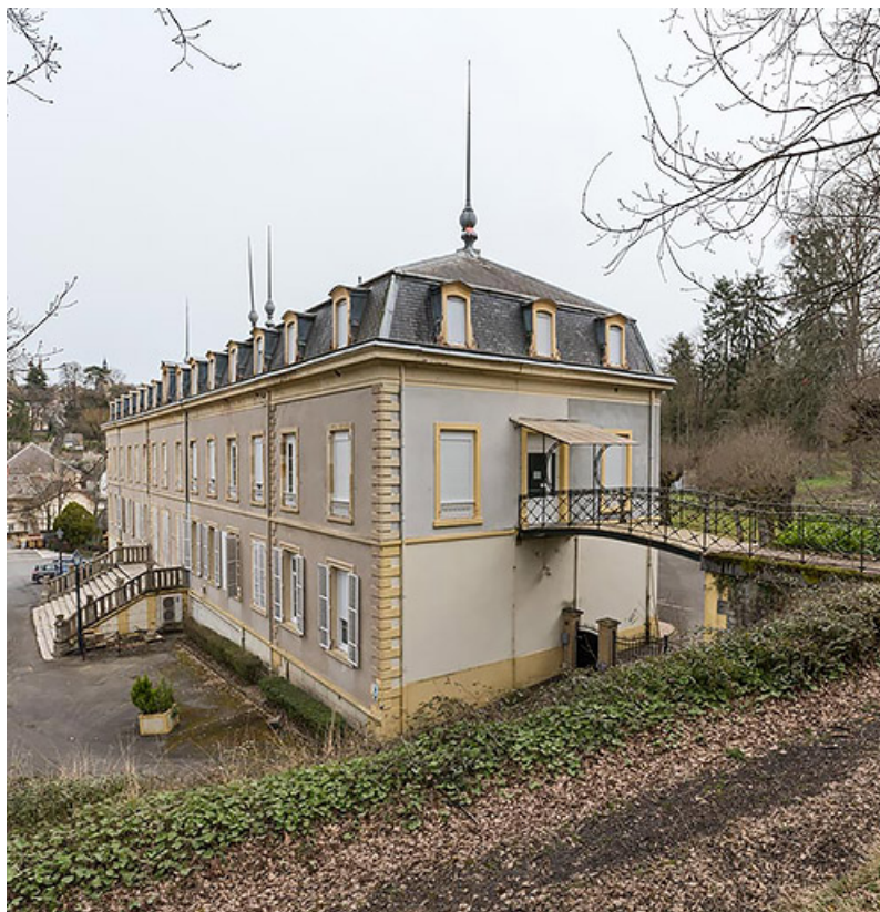
Aile nord, vue d'ensemble.
