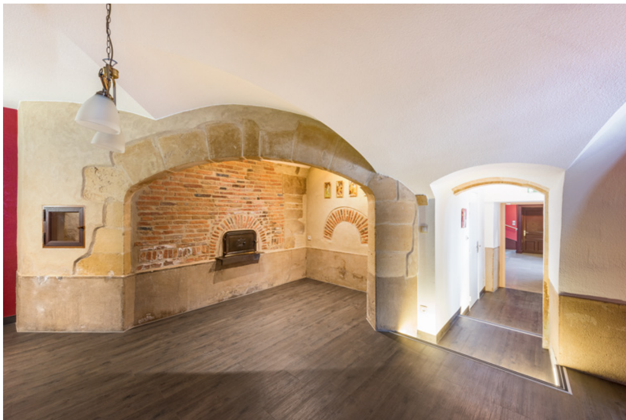
Vue intérieure du rez-de-chaussée.
