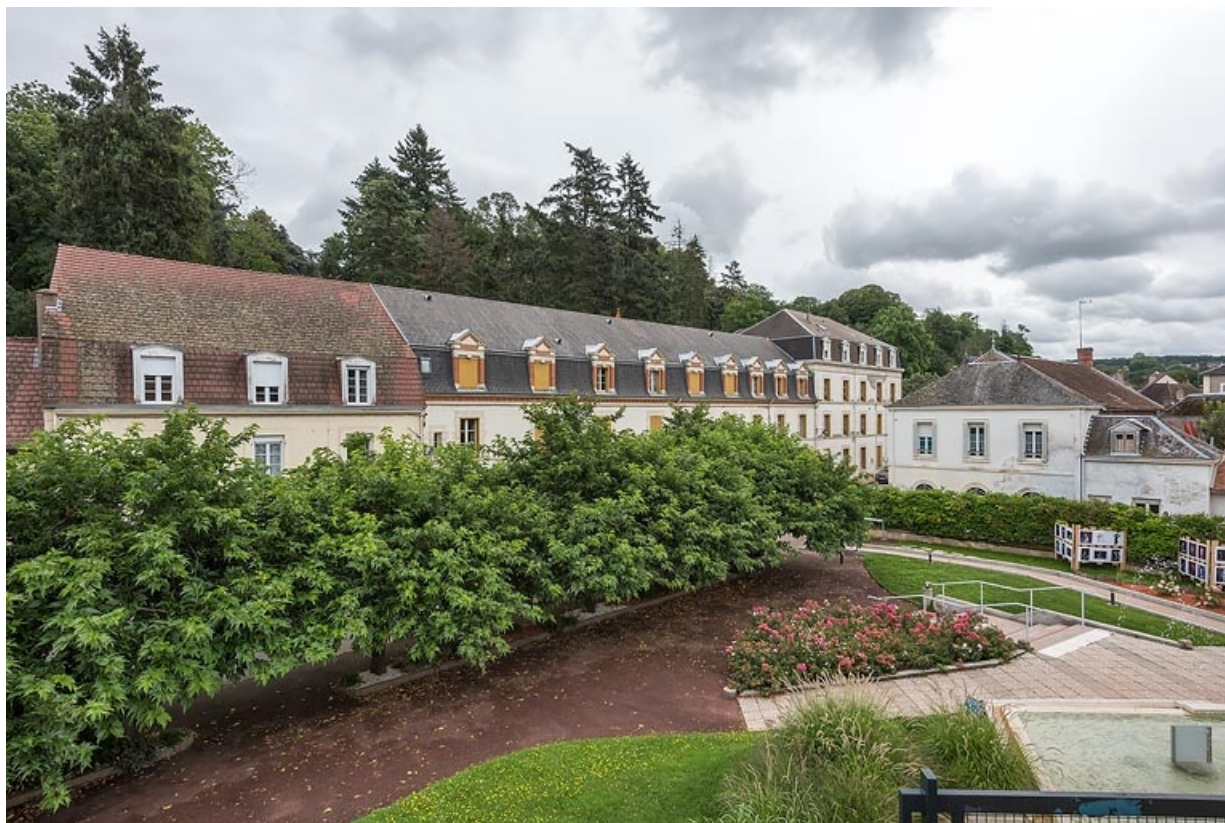
Toits brisés du bâtiment des services (en bitume) et de l'hôtel (en ardoise). 71, Bourbon-Lancy
