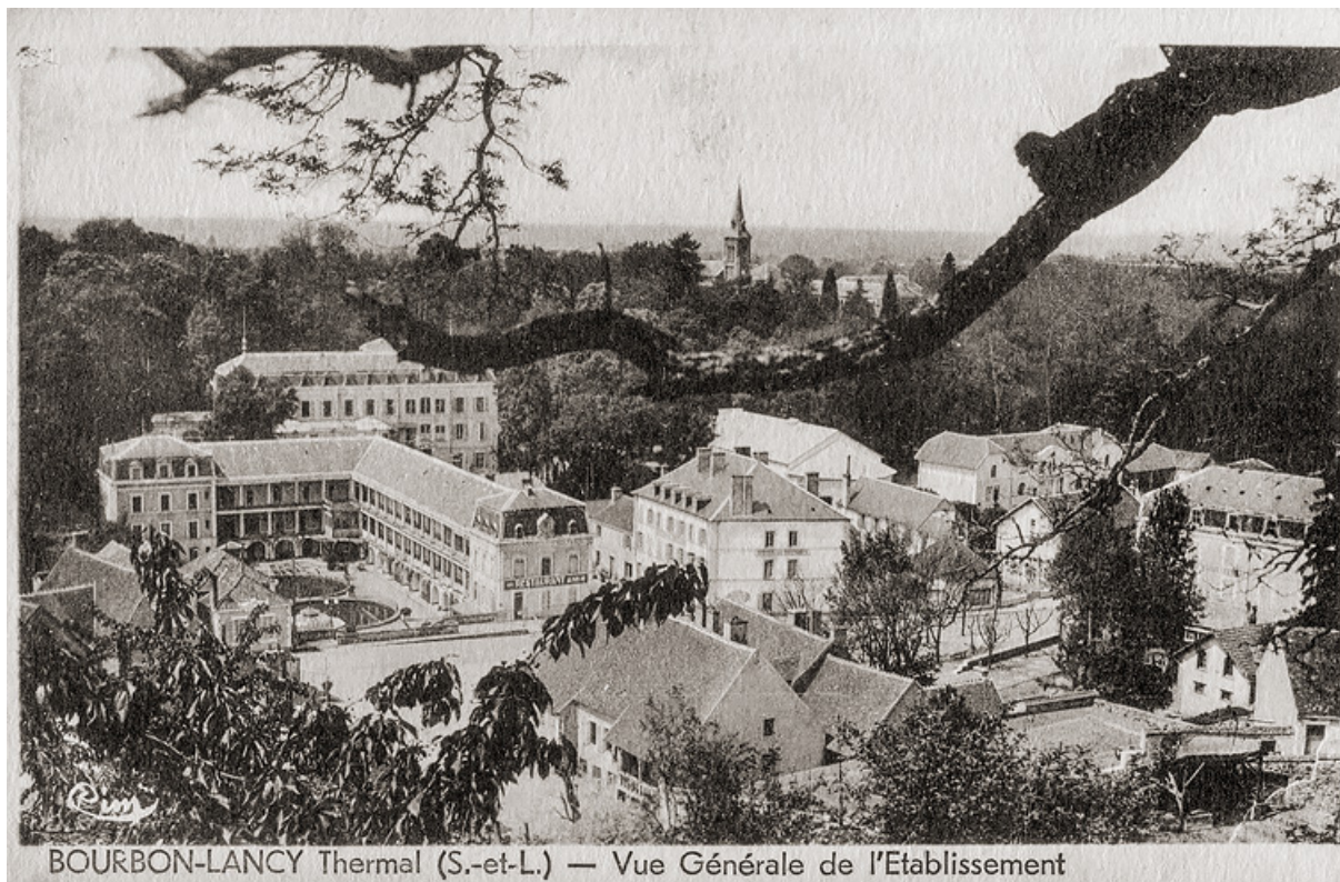
Vue ancienne du quartier thermal.
