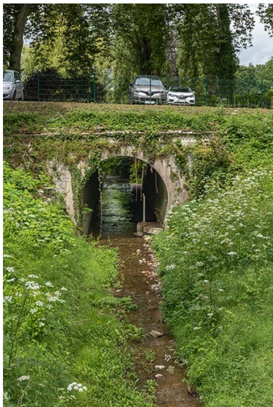
Tunnel du Borne sous l'allée d'Aligre.
