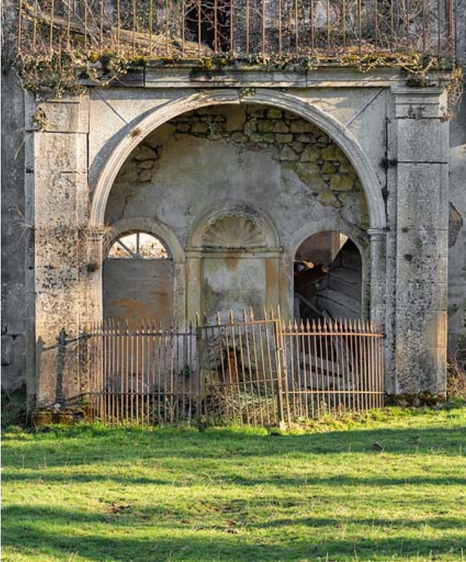
Pavillon de la source, vue rapprochée de face.
