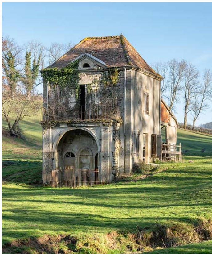
Pavillon de la source, vue de trois quarts.
