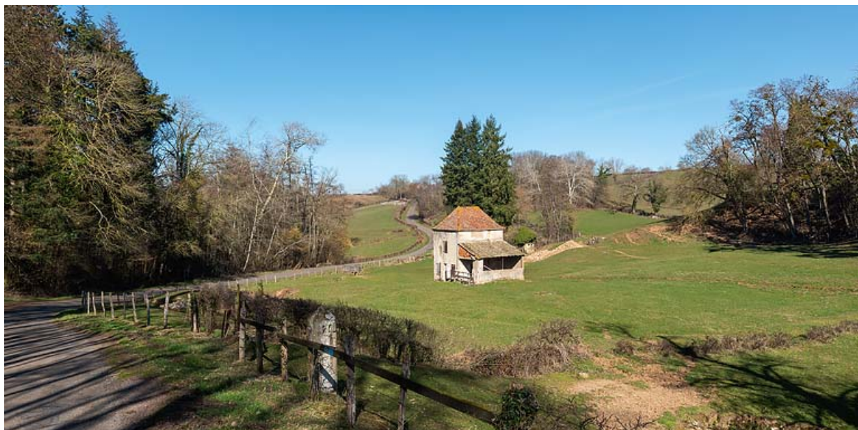
Vue générale du site, prise depuis la route (vue de l'arrière du pavillon de la source).
