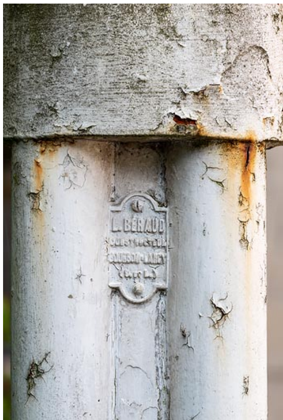
Lampadaire à l'origine entre les deux bassins de refroidissement, plaque de firme (L. Béraud). 71, Bourbon-Lancy, 2 Parc thermal
