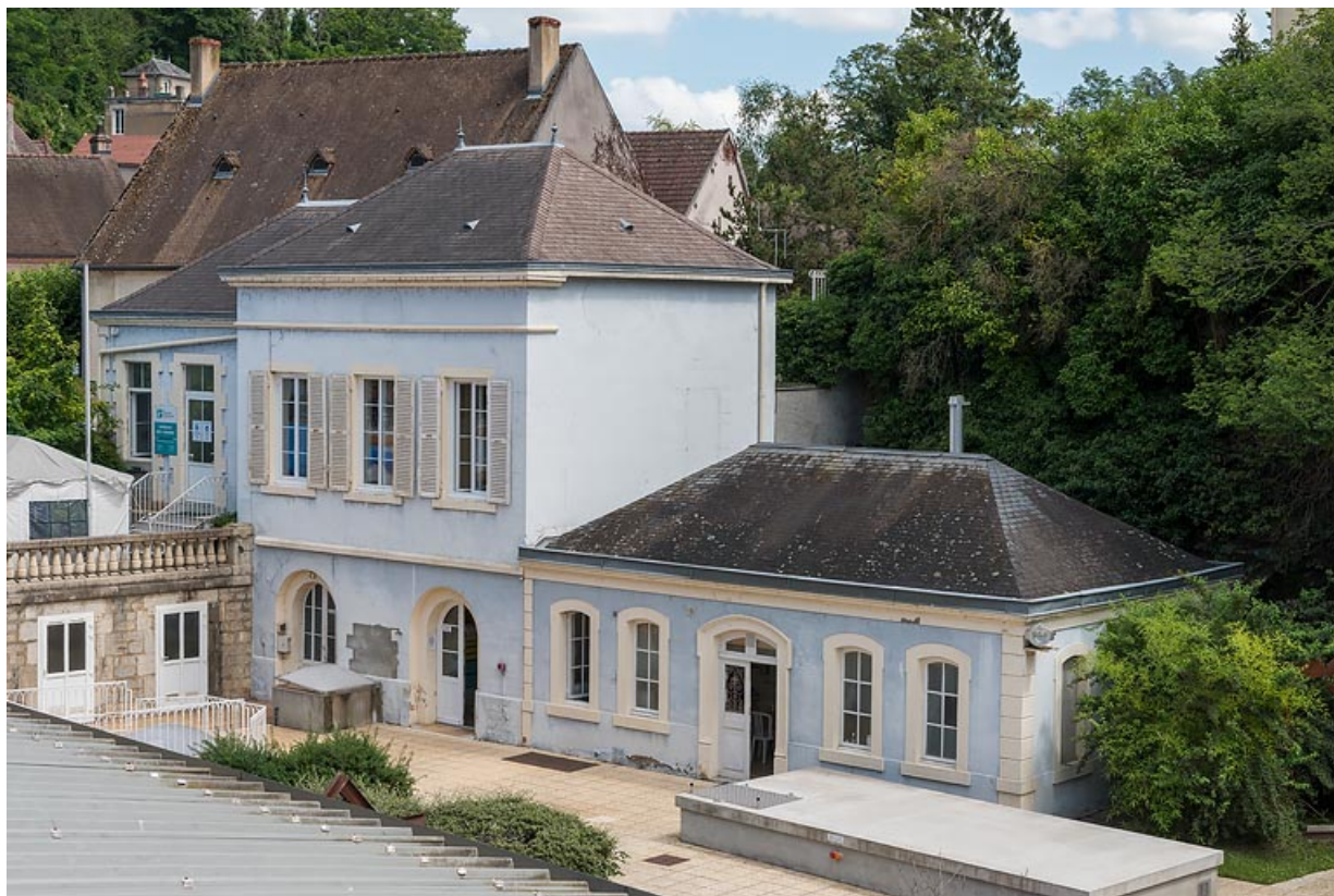
Pavillon d'hydrothérapie et pavillon des étuves, actuellement bureaux de l'administration. 71, Bourbon-Lancy, 2 Parc thermal
