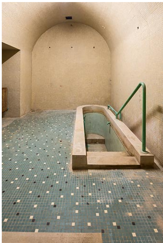
Ancienne cabine de bain, au rez-de-chaussée.
