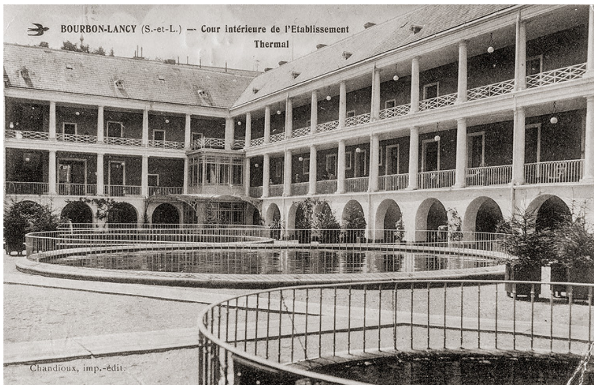
Cour des bains, façades avec galeries ouvertes aux étages. 71, Bourbon-Lancy, 2 Parc thermal
