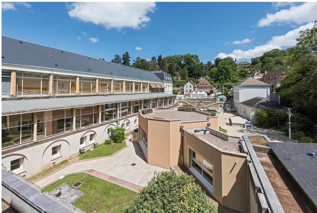
Cour des bains avec ses extensions récentes (piscine et couloir de marche). 71, Bourbon-Lancy, 2 Parc thermal
