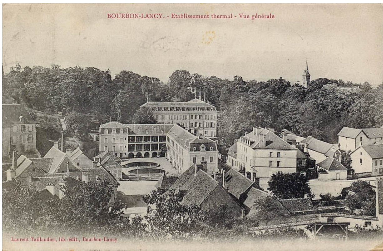
Vue d'ensemble du site (début du 20e siècle).
