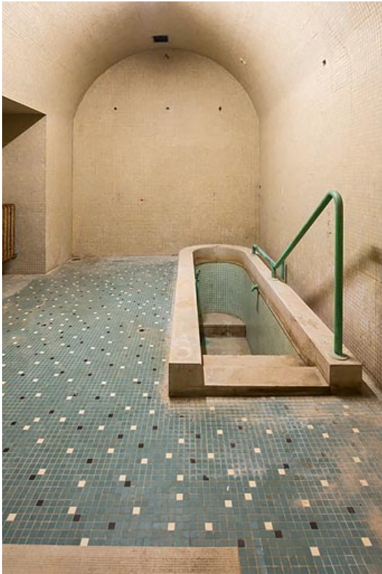
Ancienne cabine de bain, au rez-de-chaussée.
