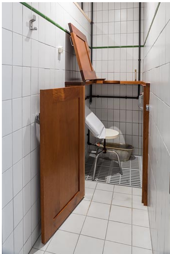
Étuves locales, au rez-de-chaussée (pavillon annexe de 1897). 71, Bourbon-Lancy, 2 Parc thermal
