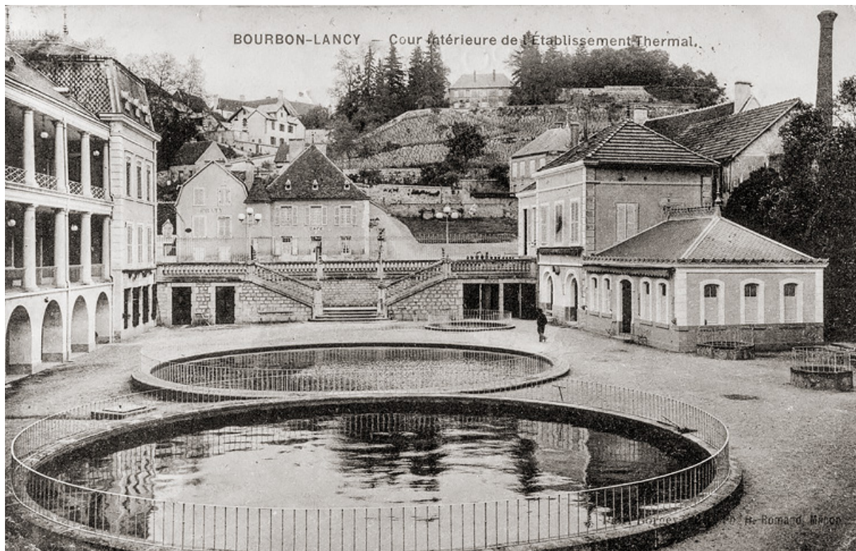
Vue ancienne de la cour de l'établissement thermal, avec la ville à l'arrière. 71, Bourbon-Lancy
