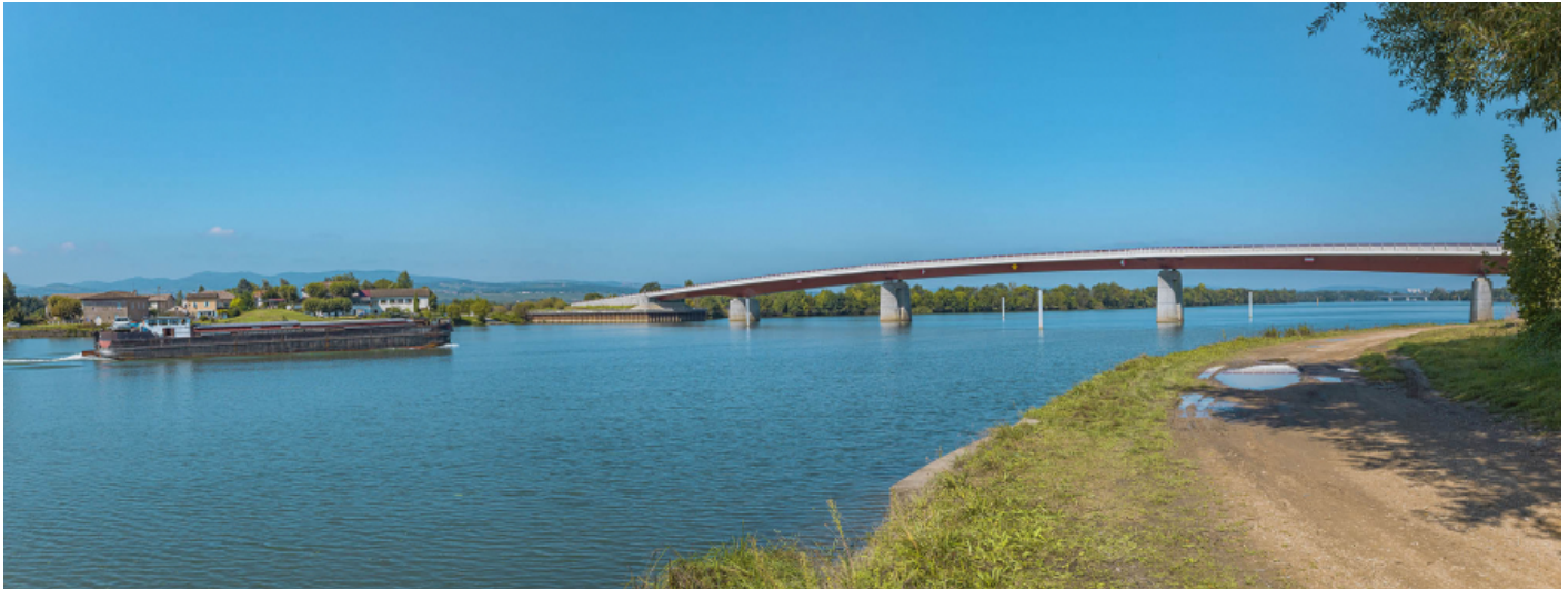
Vue d'ensemble du port et du pont d'Arciat, depuis la rive gauche de la Saône. 71, Crêches-sur-Saône route départementale 31, lieudit : PK 72,8
