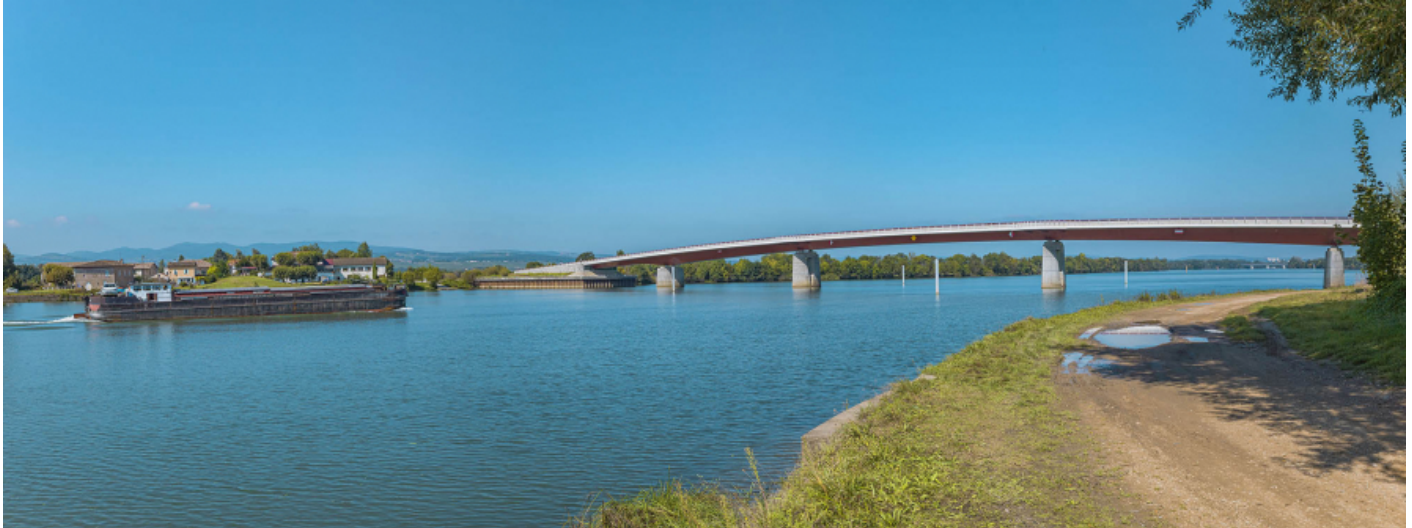
Vue d'ensemble du port et du pont d'Arciat, depuis la rive gauche de la Saône. 71, Crêches-sur-Saône route départementale 31, lieudit : PK 72,8
