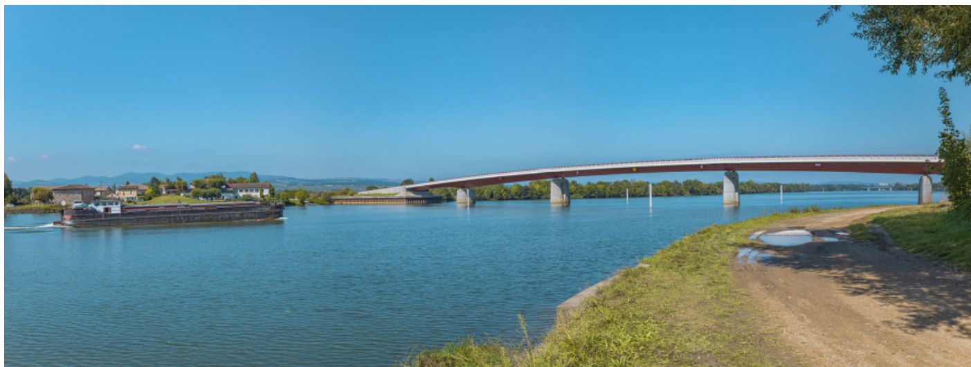
Vue d'ensemble du port et du pont d'Arciat, depuis la rive gauche de la Saône. 71, Crêches-sur-Saône route départementale 31, lieudit : PK 72,8
