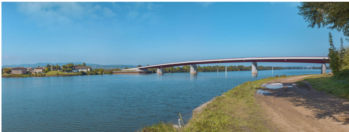
Vue d'ensemble du port et du pont d'Arciat, depuis la rive gauche de la Saône. 71, Crêches-sur-Saône route départementale 31, lieudit : PK 72,8
