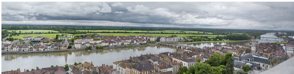
Vue panoramique de la traversée de Mâcon. 71, Mâcon
