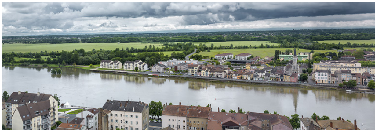
Vue panoramique de la traversée de Mâcon depuis l'amont.
