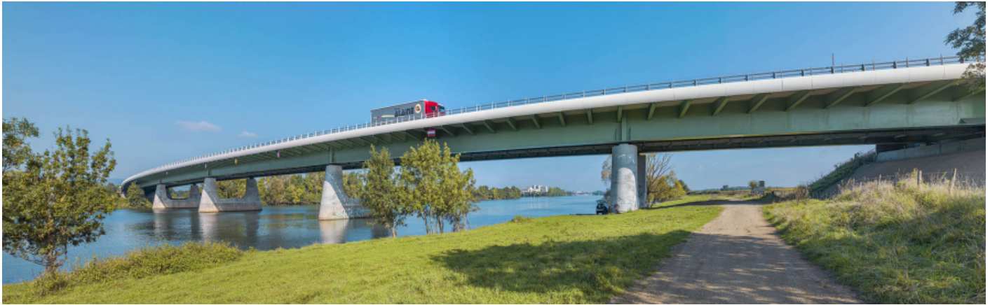
Pont supportant l'autoroute A 406, vu d'aval, depuis le chemin de halage rive gauche. 71, Varennes-lès-Mâcon, lieudit : PK 76,5
