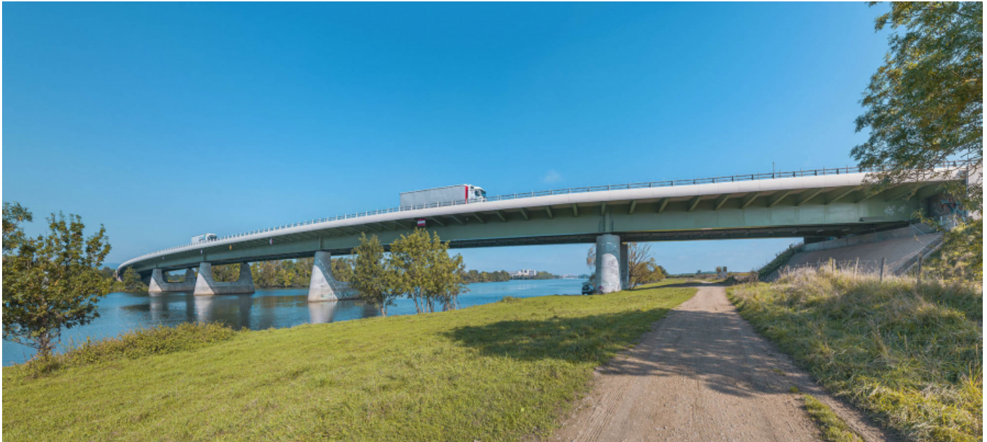
Le pont de l'autoroute A406, vu d'aval, depuis le chemin de halage rive gauche. 71, Varennes-lès-Mâcon, lieudit : PK 76,5
