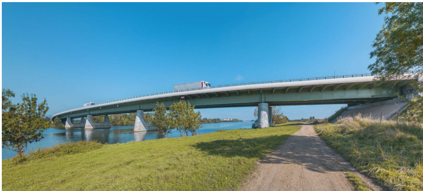
Le pont de l'autoroute A406, vu d'aval, depuis le chemin de halage rive gauche.
