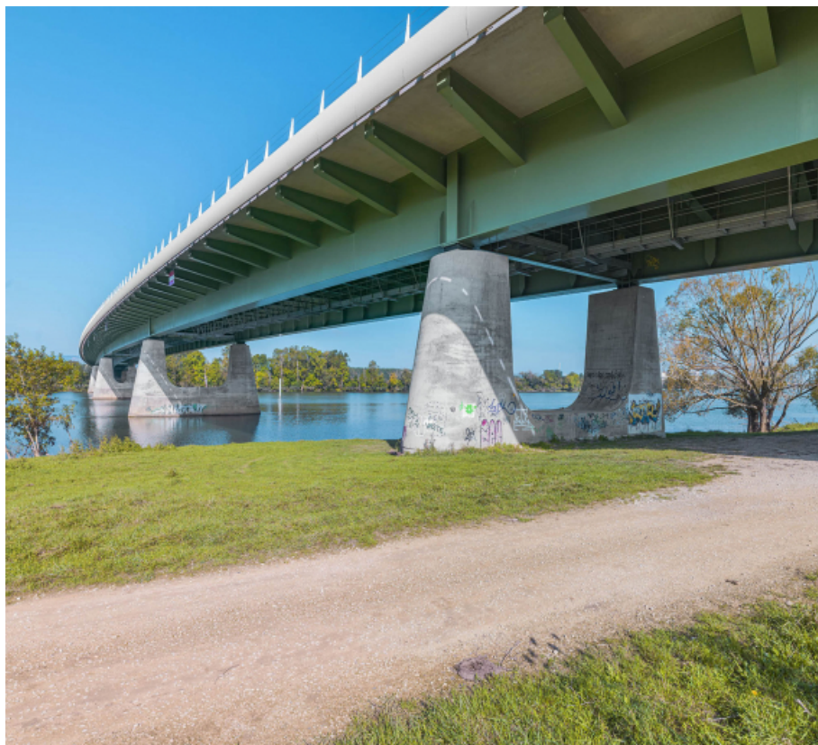
Détail des piles et du tablier du pont de l'A406, depuis la rive gauche.
