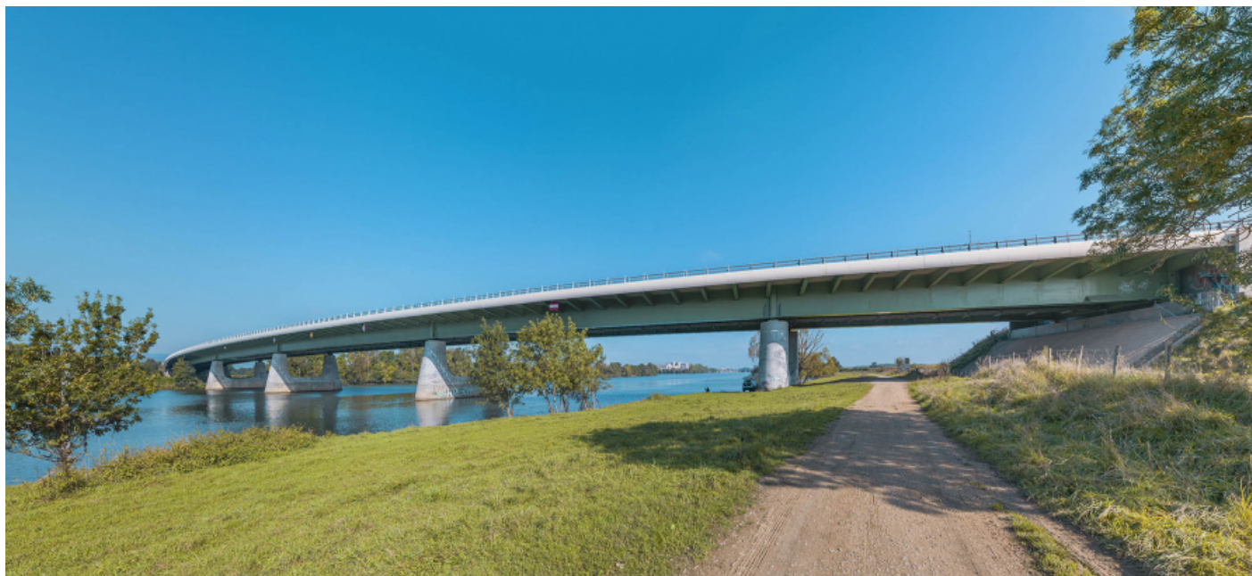
Le pont de l'A406 vu d'aval, depuis la rive gauche.
