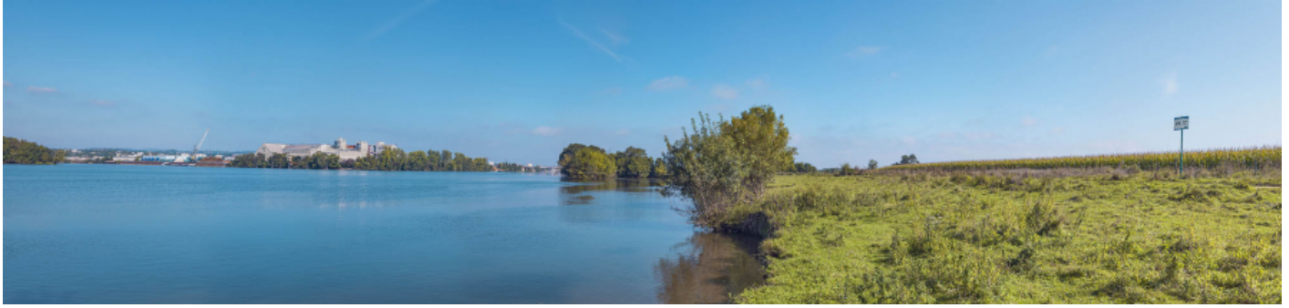
Le port de commerce de Mâcon, vu depuis la rive gauche à hauteur du PK 77. 71, Mâcon rue de la Grosne, lieudit : PK 77
