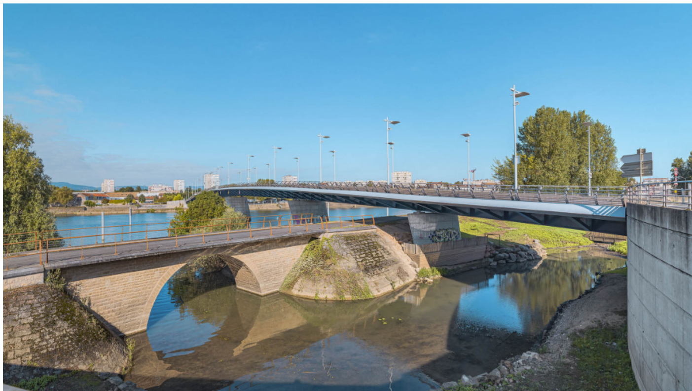
Le pont vu depuis la rive gauche. Au premier plan, le pont sur la Veyle. 71, Mâcon route départementale 879, lieu-dit : PK 79,5
