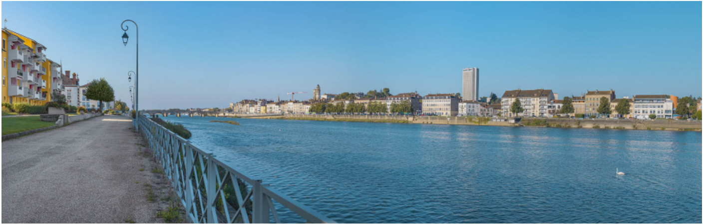
Quais du Breuil et Jean-Jaurès, en amont du pont Saint-Laurent, vus depuis la rive gauche.
