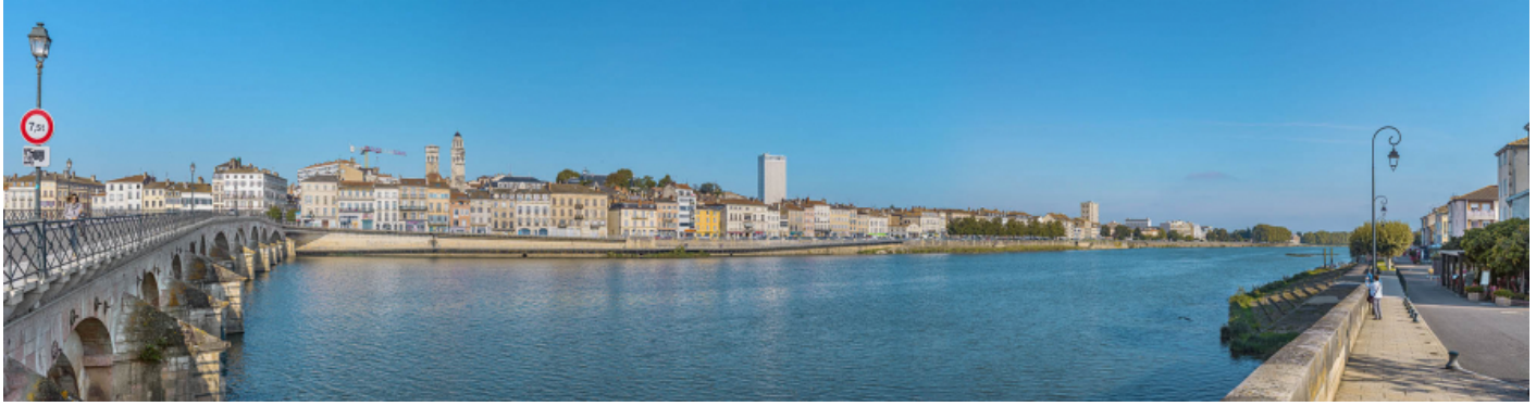
Quai Jean-Jaurès, en amont du pont Saint-Laurent, vus depuis la rive gauche.
