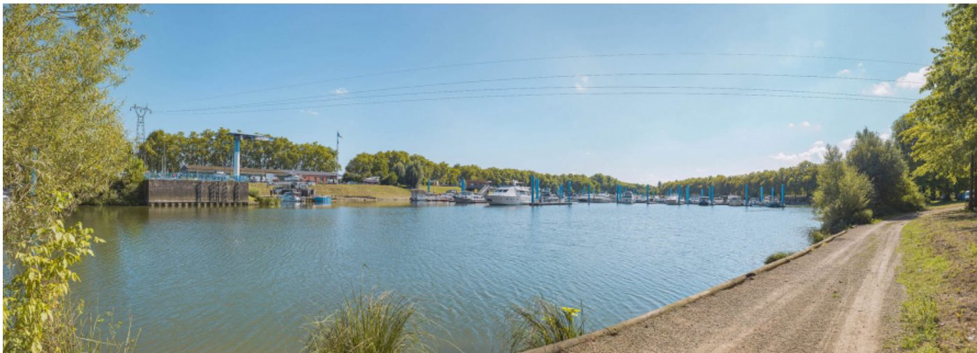
Le port de plaisance de Mâcon, vu d'amont, juste après le chenal d'entrée.
