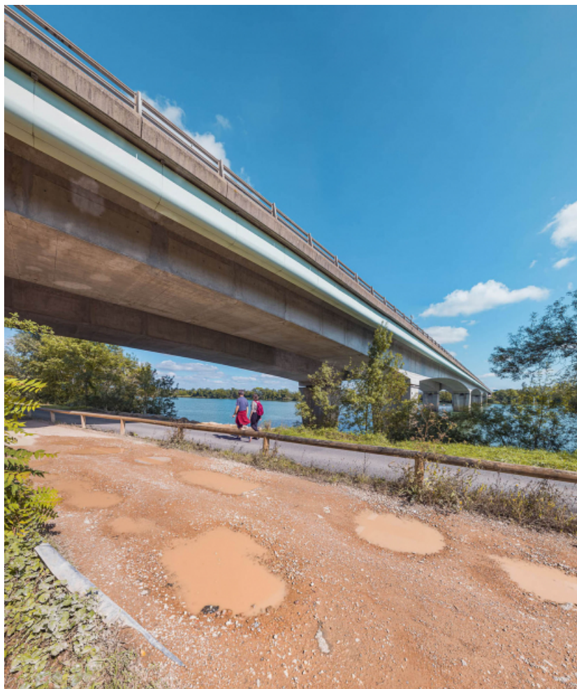
Le pont depuis la véloroute, rive droite.
