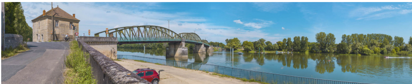
Le pont de Fleurville, vu d'aval, depuis la rive droite. La maison pontière se trouve au premier plan.
