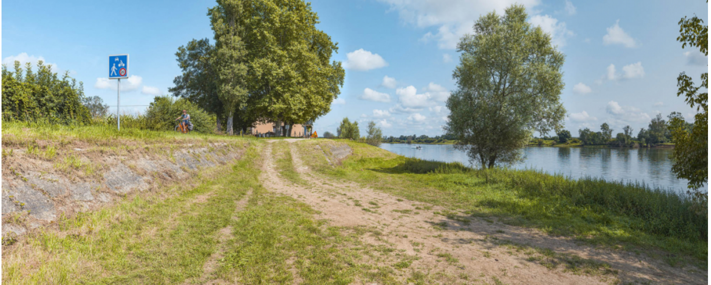
Les perrés du port de Jean-de-Saône vus d'aval.
