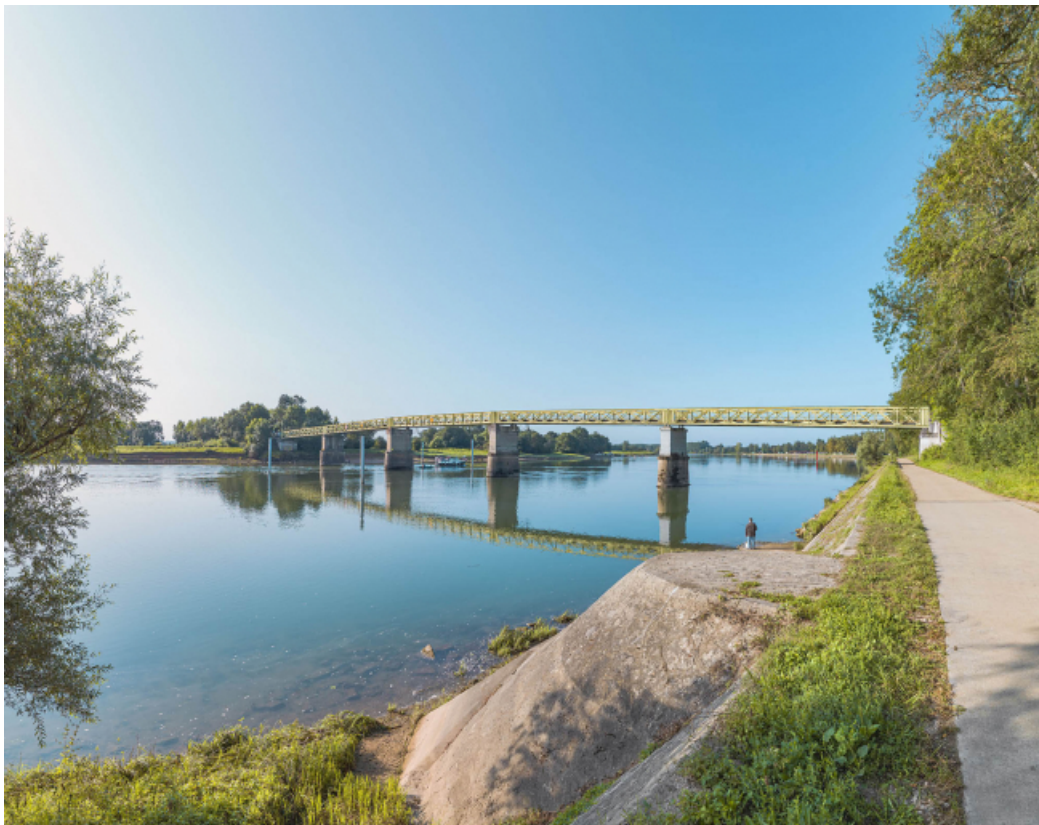
Vue d'ensemble du pont d'amont et depuis la rive droite. Perrés et rampe au premier plan. 71, Uchizy route départementale 163, lieudit : PK 103,2
