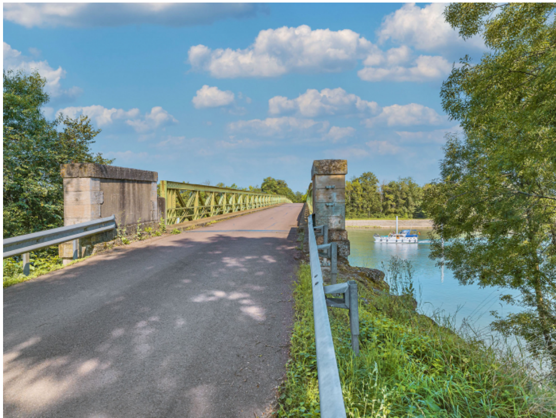
Vue du dessus du pont, rive gauche.
