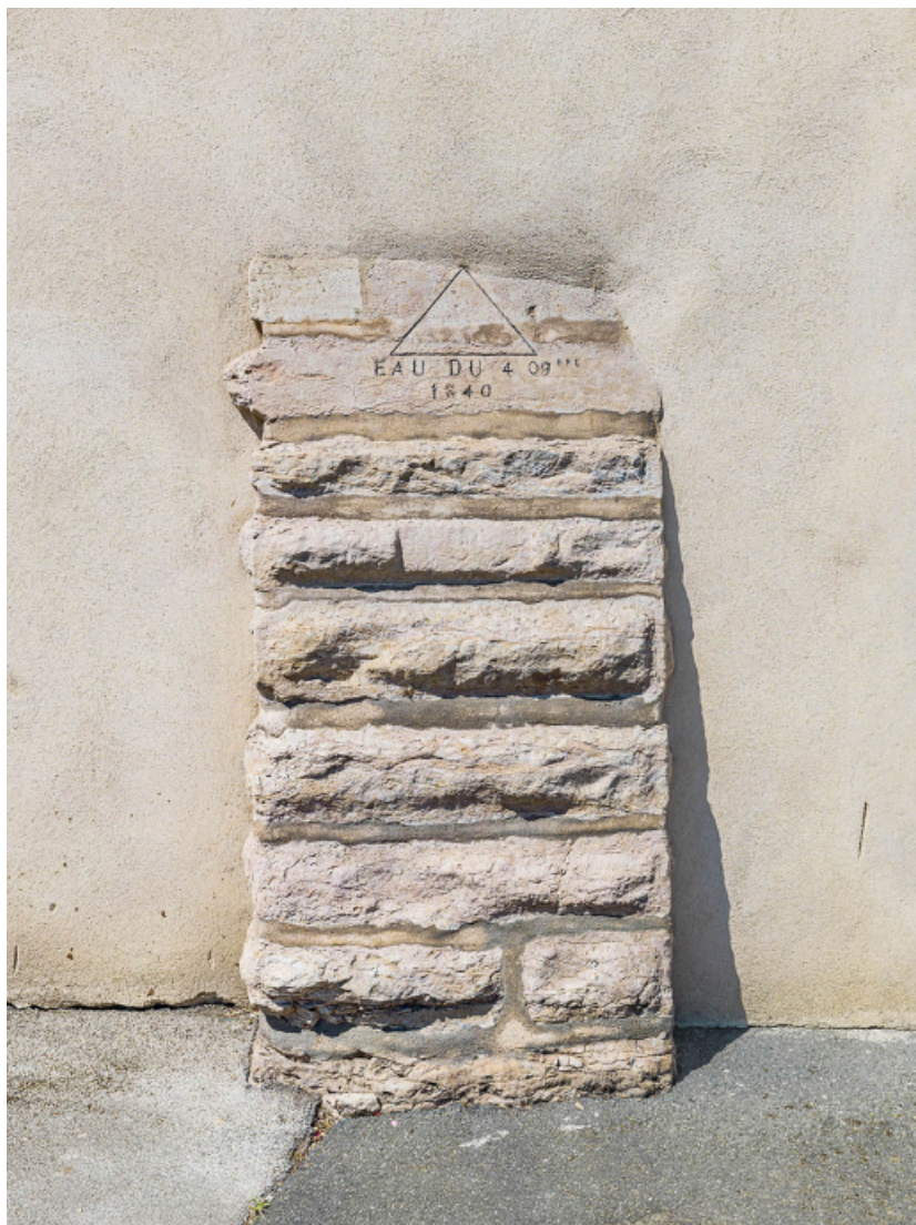
Détail du repère de la crue du 4 novembre 1840 sur une maison quai du Midi. 71, Tournus
