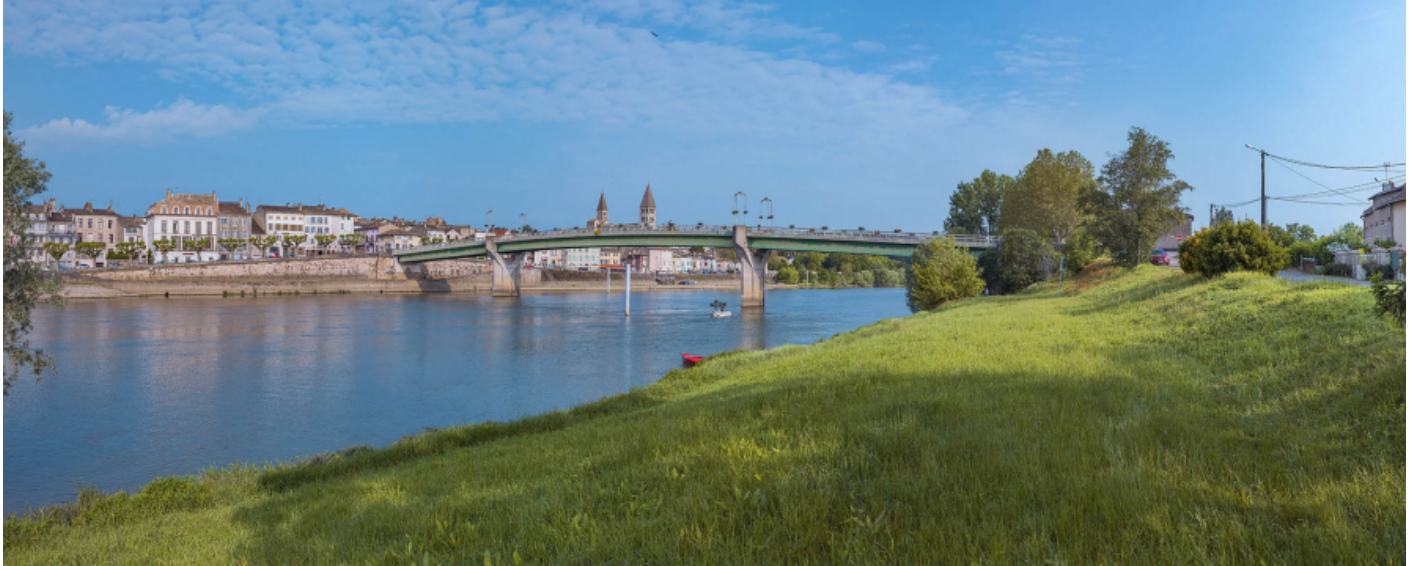
Le pont de Tournus, vu d'aval, depuis la rive gauche.
