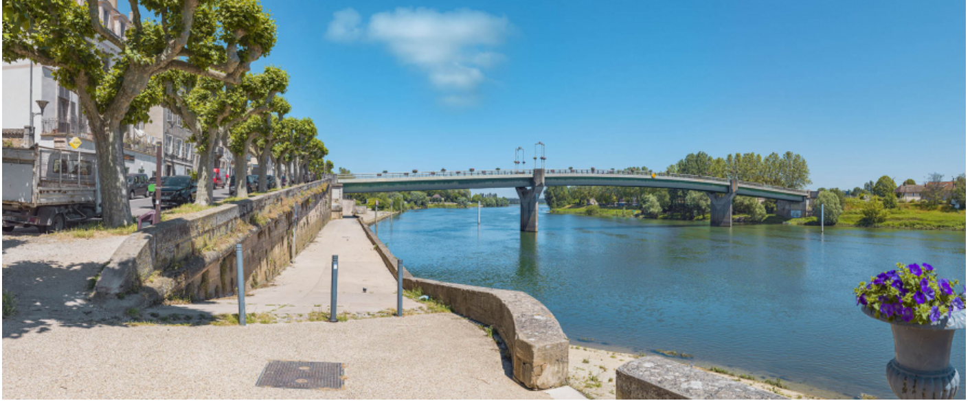
Le pont de Tournus, vu d'aval, au niveau de la banquette de halage.
