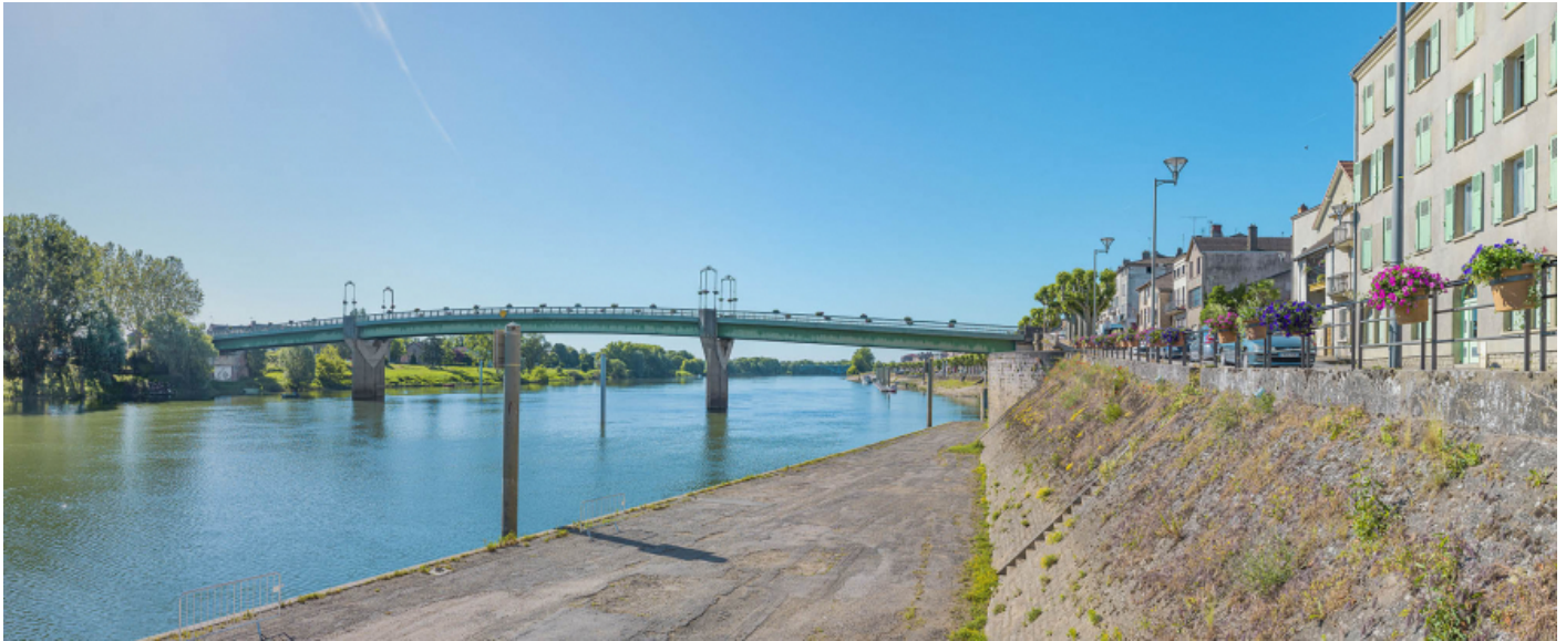
Le pont de Tournus, vu d'amont, rive droite. 71, Tournus rue Jean Jaurès, lieu dit : PK 110,9
