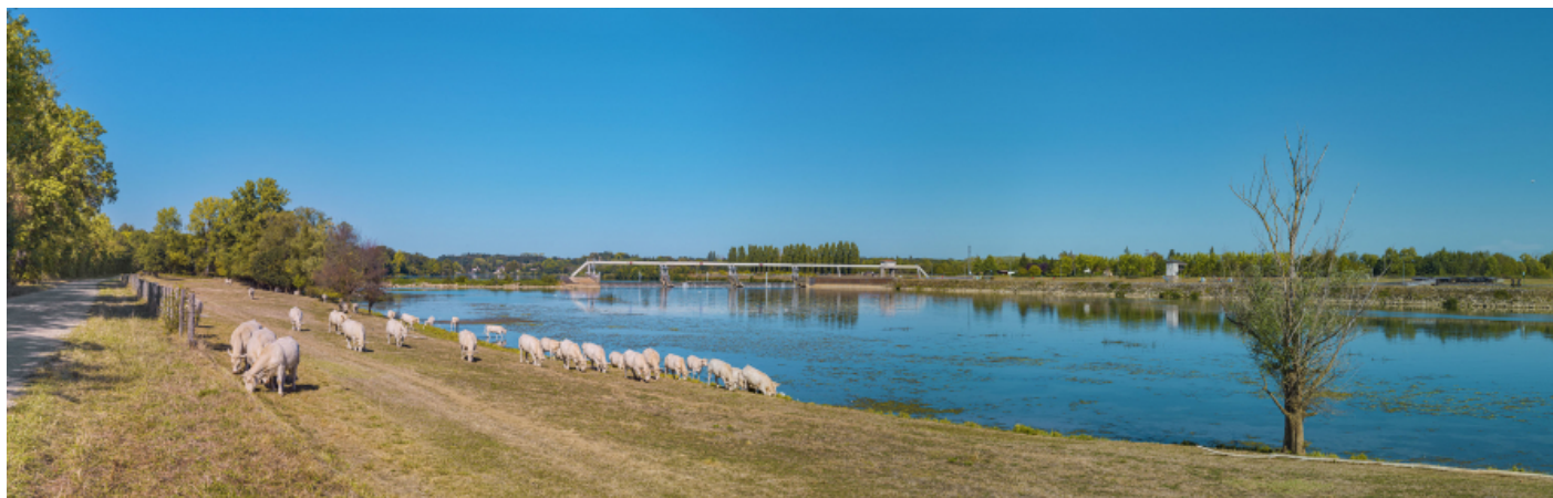
Vue d'ensemble des perrés et du barrage d'Ormes en arrière-plan.
