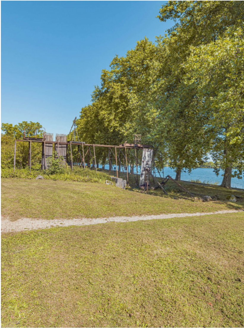
Les vestiges de l'ancien barrage de Thoisse, à Mâcon.
