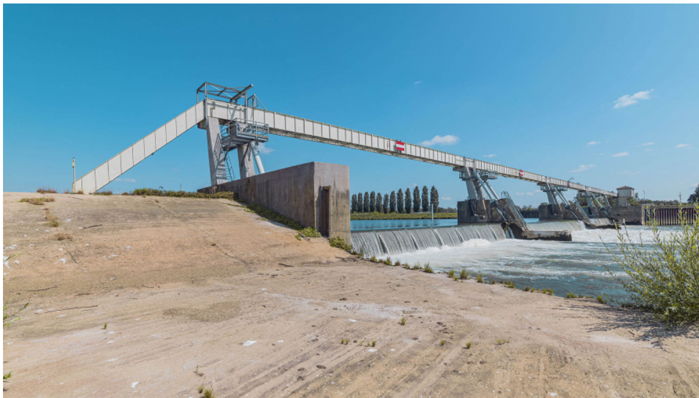
Le barrage d'Ormes vu depuis la pile ovale reliant ses deux parties.
