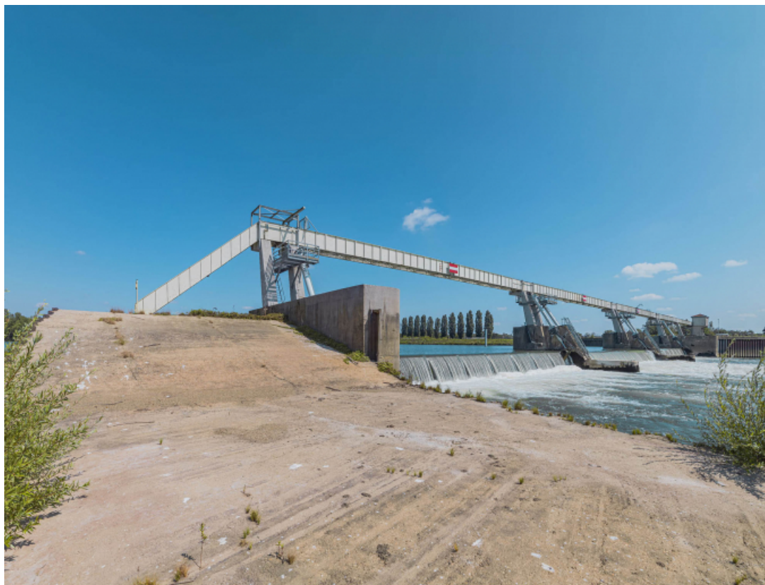
Le barrage d'Ormes vu depuis la pile ovale reliant ses deux parties.
