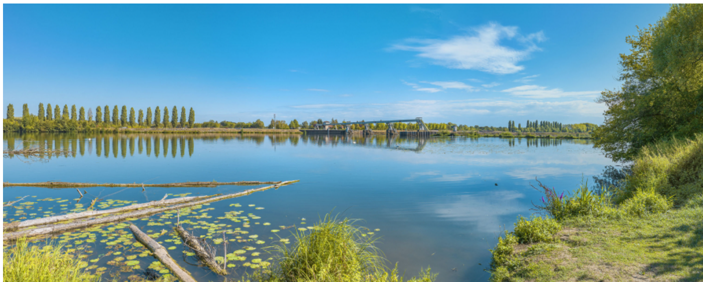
Vue d'ensemble du barrage depuis la rive opposée.
