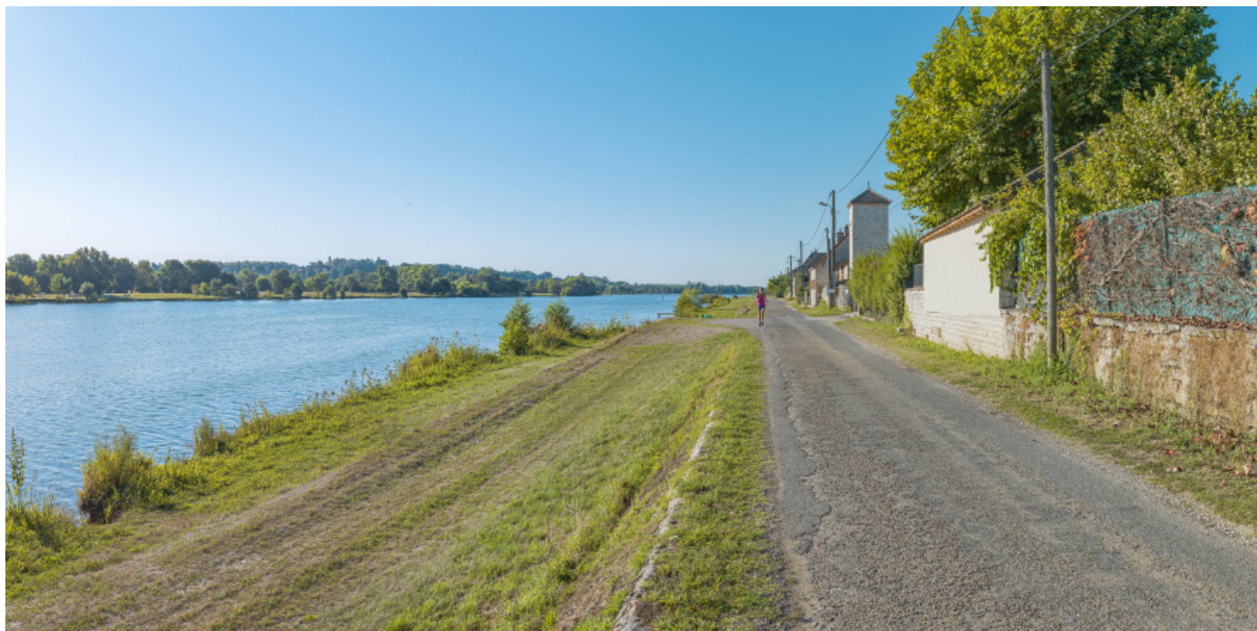
Vue d'ensemble du port de La Colonne au niveau de la cale double.
