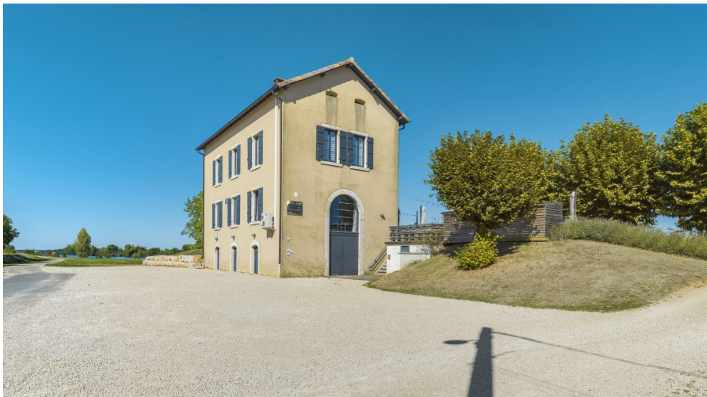
Pignon et façade postérieure de la maison.
