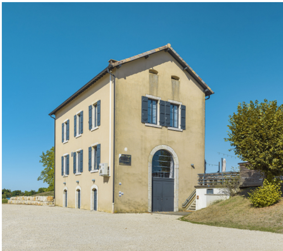
Pignon et façade postérieure de la maison.
