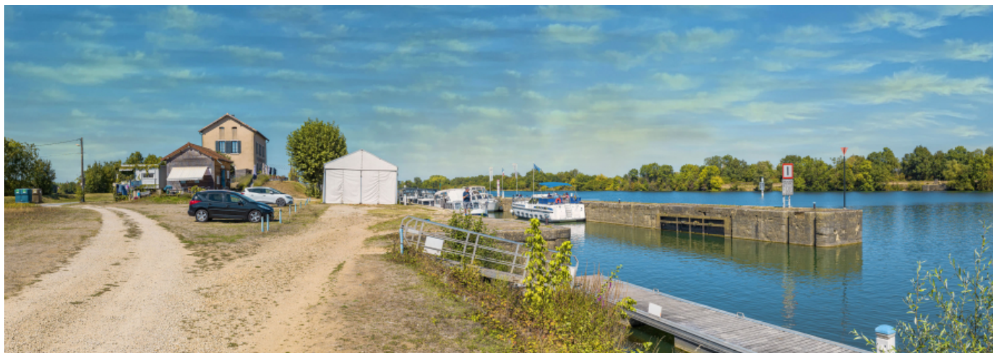
Vue d'ensemble du site de Gigny : ancienne écluse et maison, rive droite.
