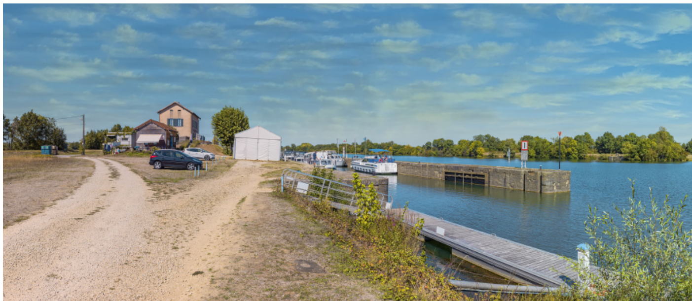
L'ancienne écluse depuis l'aval : l'entrée du port de plaisance.
