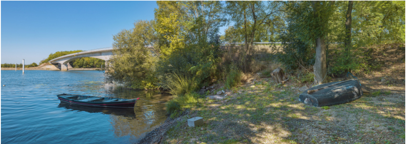
Vue d'ensemble du pont de Thorey, rive gauche, d'aval.
