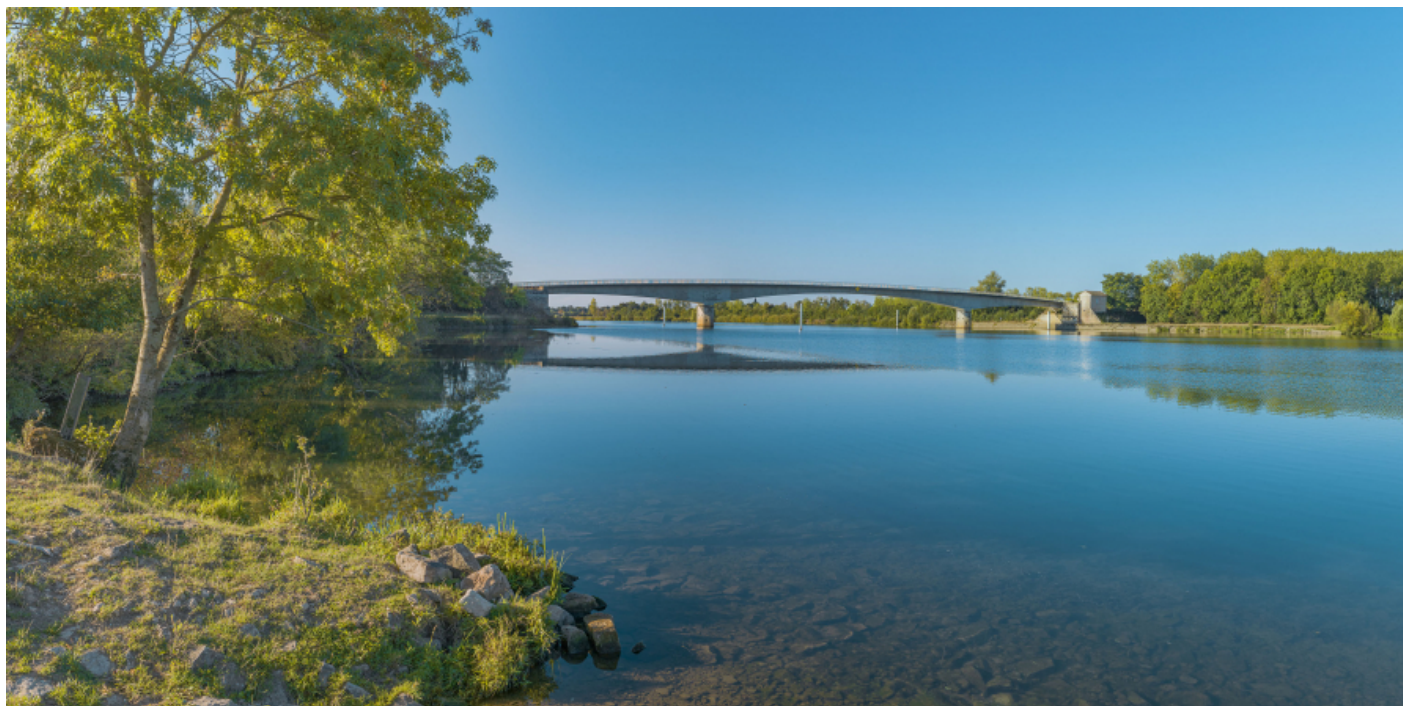
Vue d'ensemble du pont de Thorey depuis la rive gauche.
