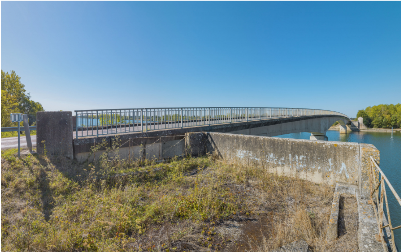
Vue d'ensemble du pont de Thorey depuis la culée de la rive gauche.
