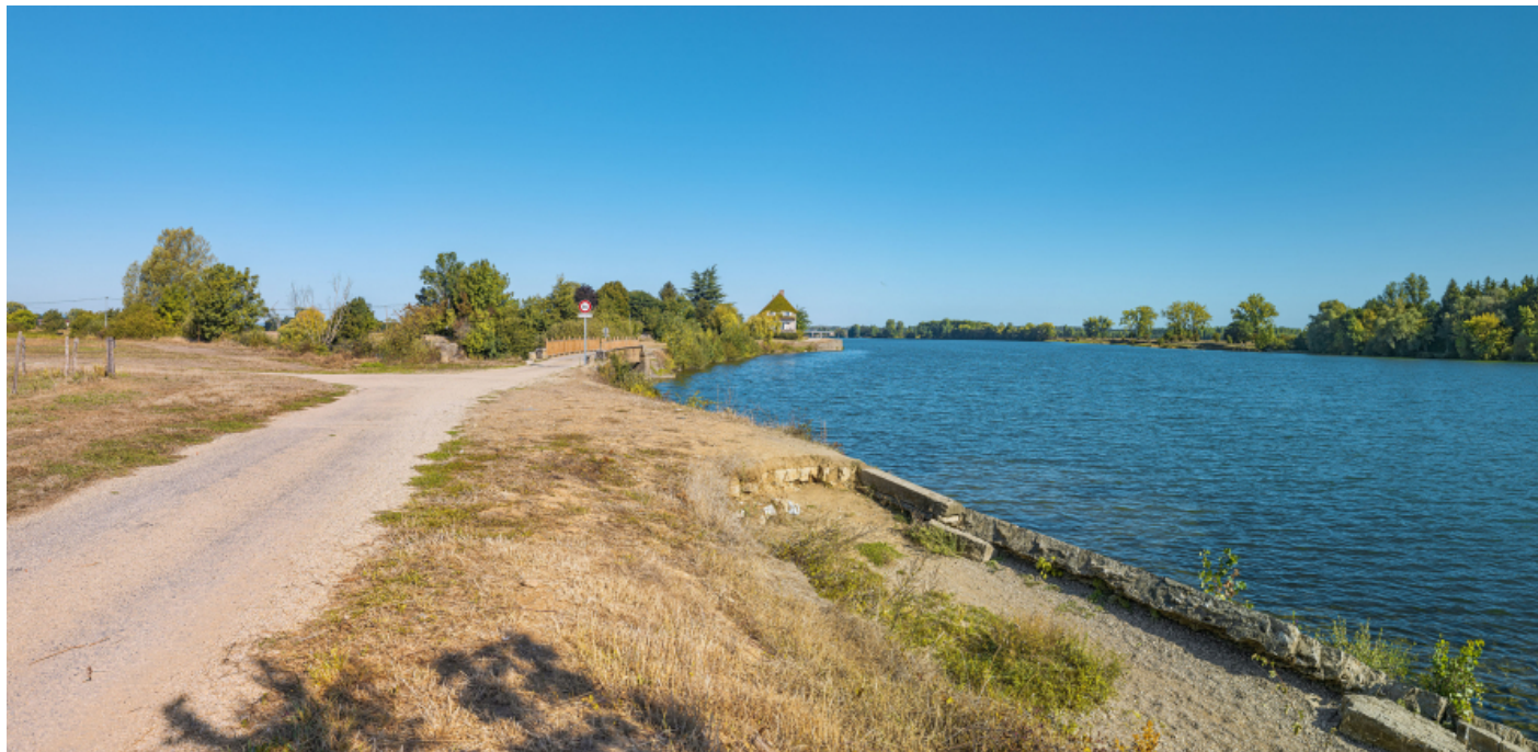
Le pont sur la Grosne et le port de Grosne depuis les perrés aval.
