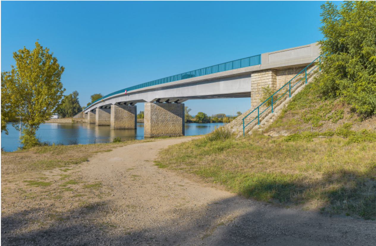
Le pont d'Ouroux, vu d'amont, depuis la rive droite.
