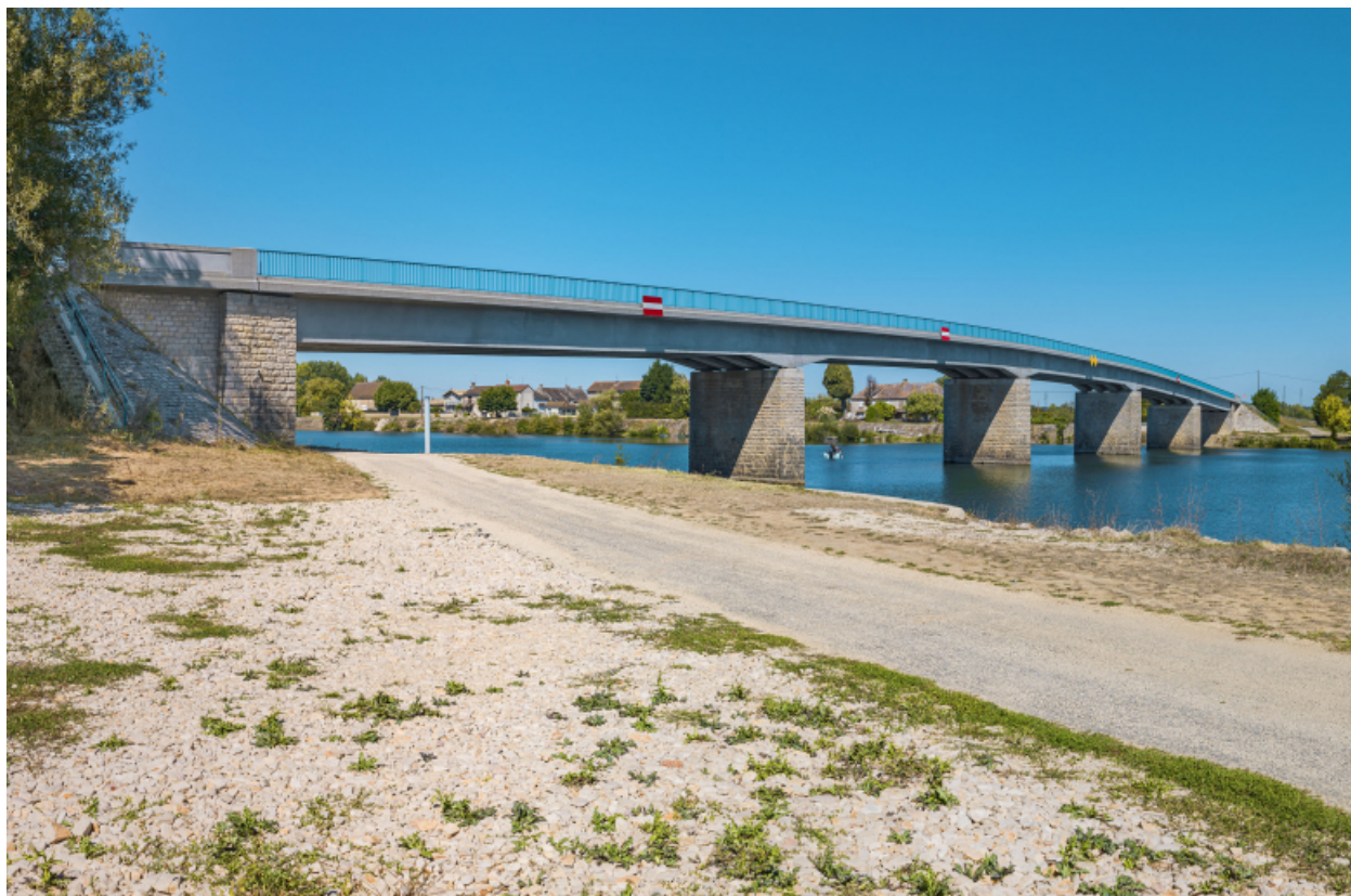
Le pont d'Ouroux, vu d'aval, depuis la rive droite.
