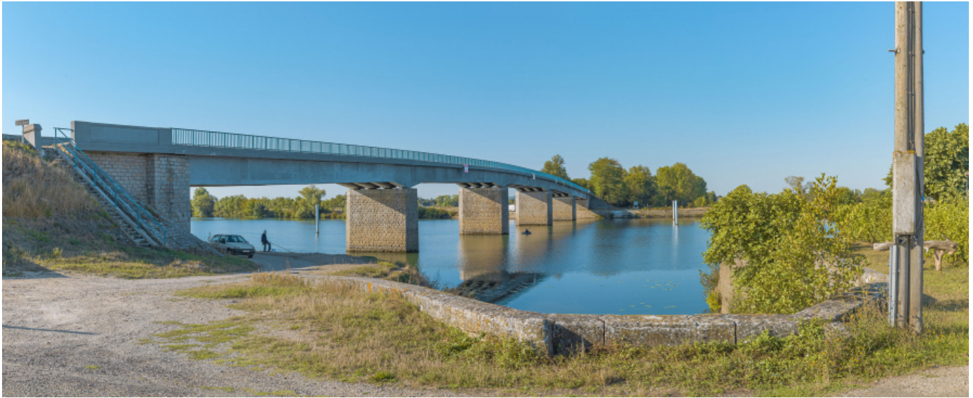
Vue d'ensemble du pont depuis la rive gauche, au niveau du port d'Ouroux.
