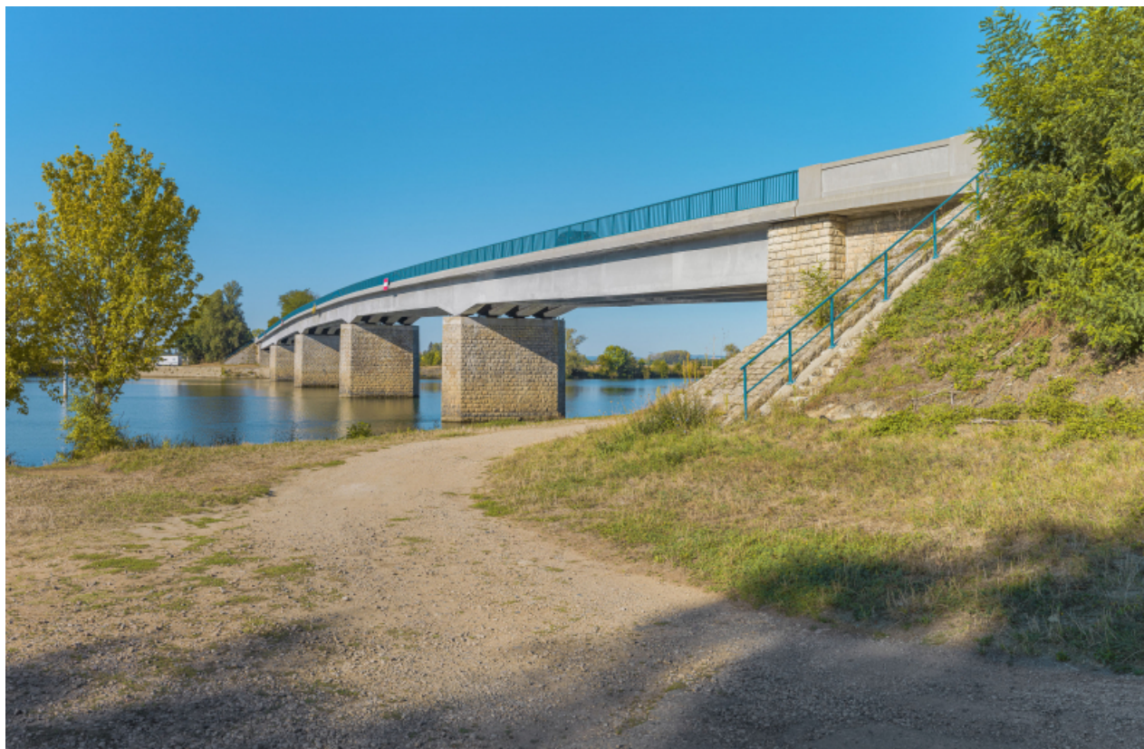
Le pont d'Ouroux, vu d'amont, depuis la rive droite.
