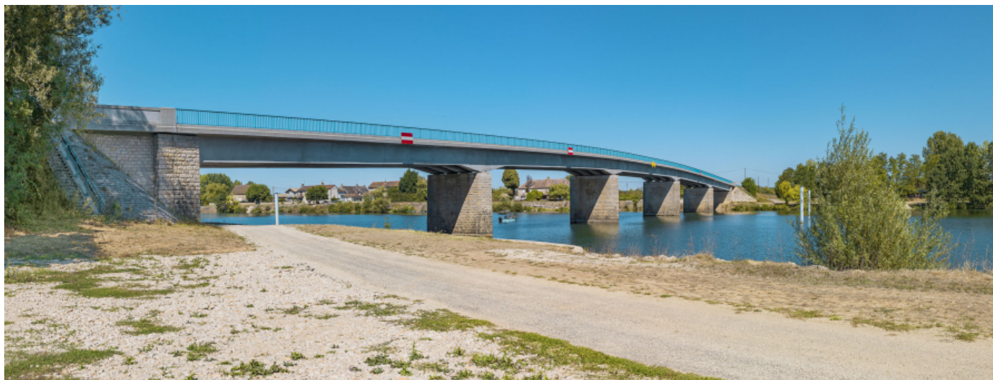
Le pont d'Ouroux, vu d'aval, depuis la rive droite.
