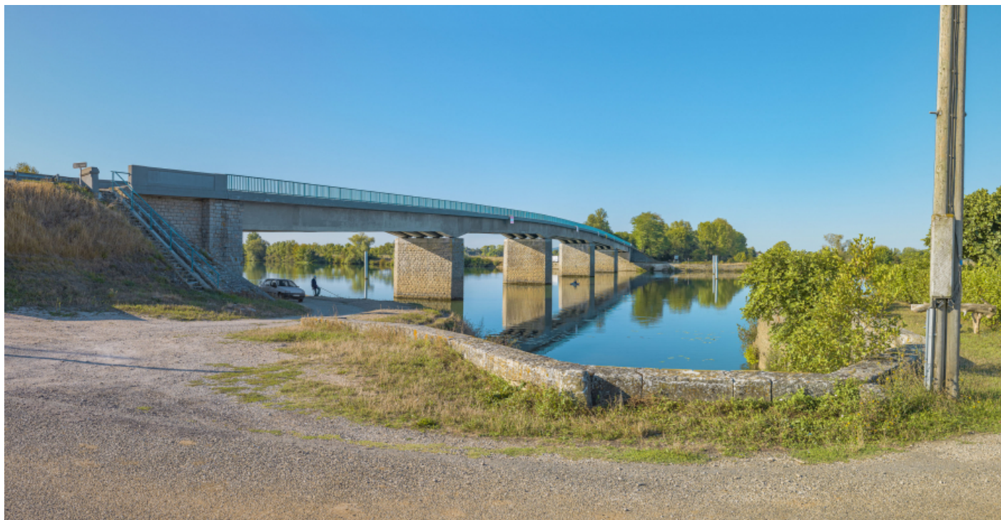
Vue d'ensemble du pont depuis la rive gauche, au niveau du port d'Ouroux.
