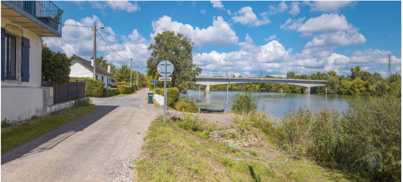
Vue d'ensemble avec le pont de Bresse en arrière-plan.
