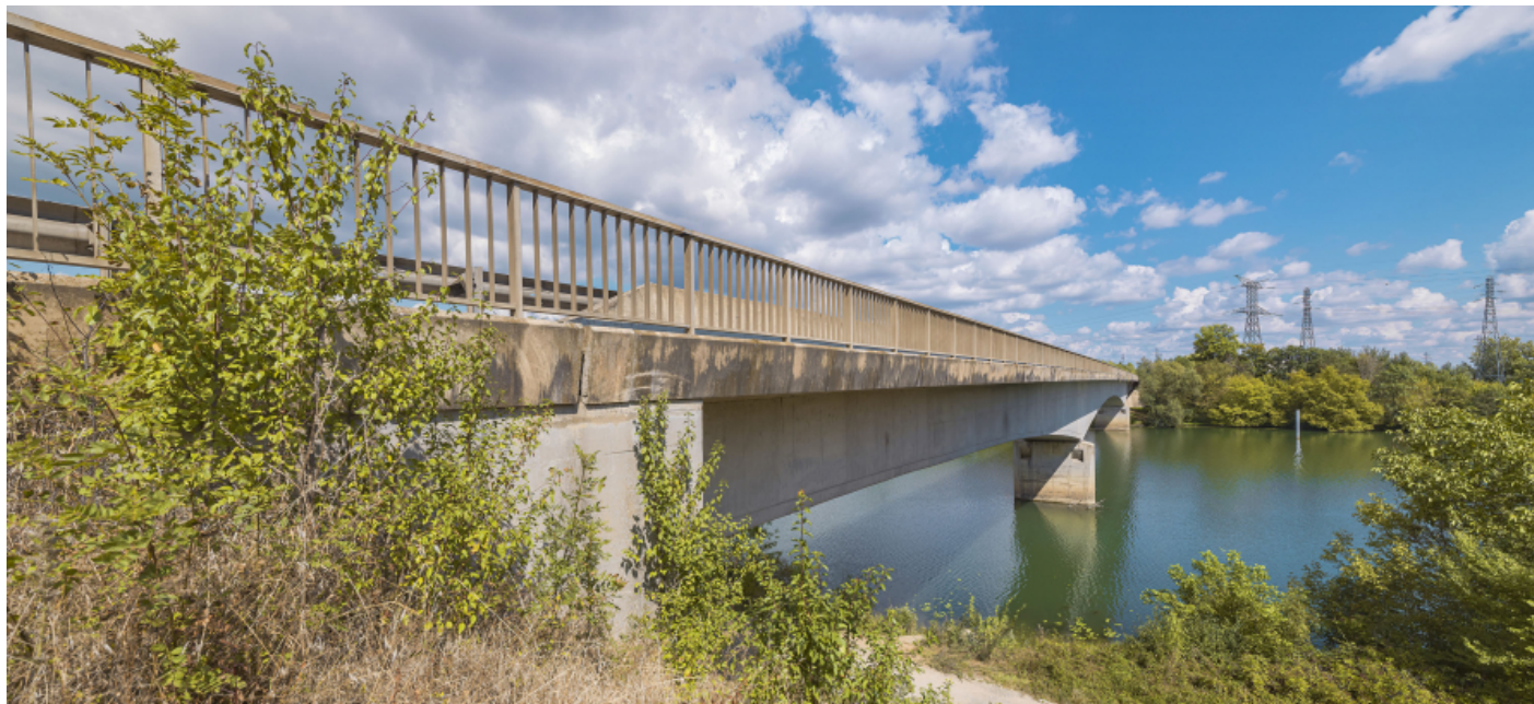
Vue d'ensemble du pont, depuis la rive droite.
