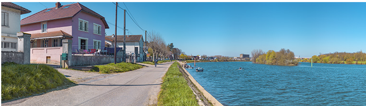
Le quai avec la rampe de mise à l'eau et ses perrés.
