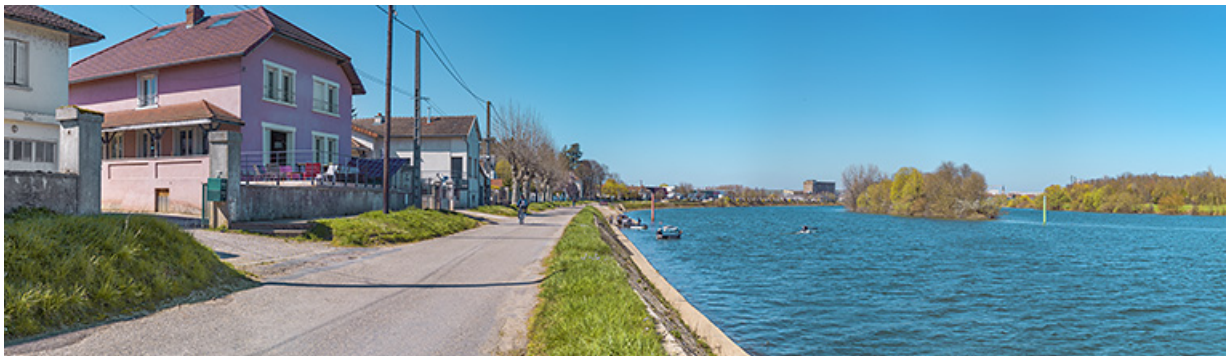
Le quai avec la rampe de mise à l'eau et ses perrés.
