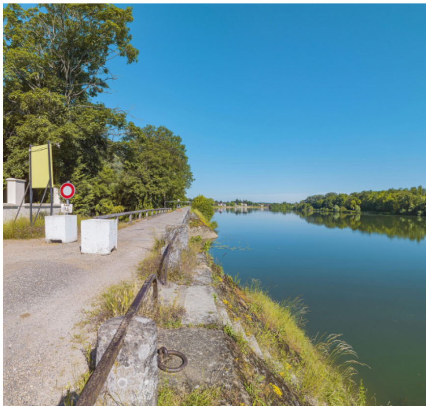
Extrémité aval du quai avec le pont sur la Roie de Droux.
