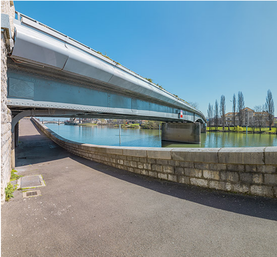
Tablier du pont vu depuis la banquette de halage.
