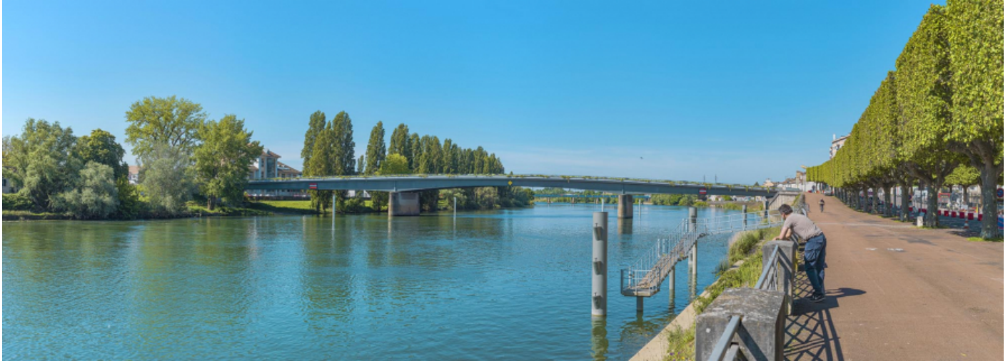
Vue d'ensemble du pont Jean-Richard depuis l'amont, au niveau du quai Gambetta.
