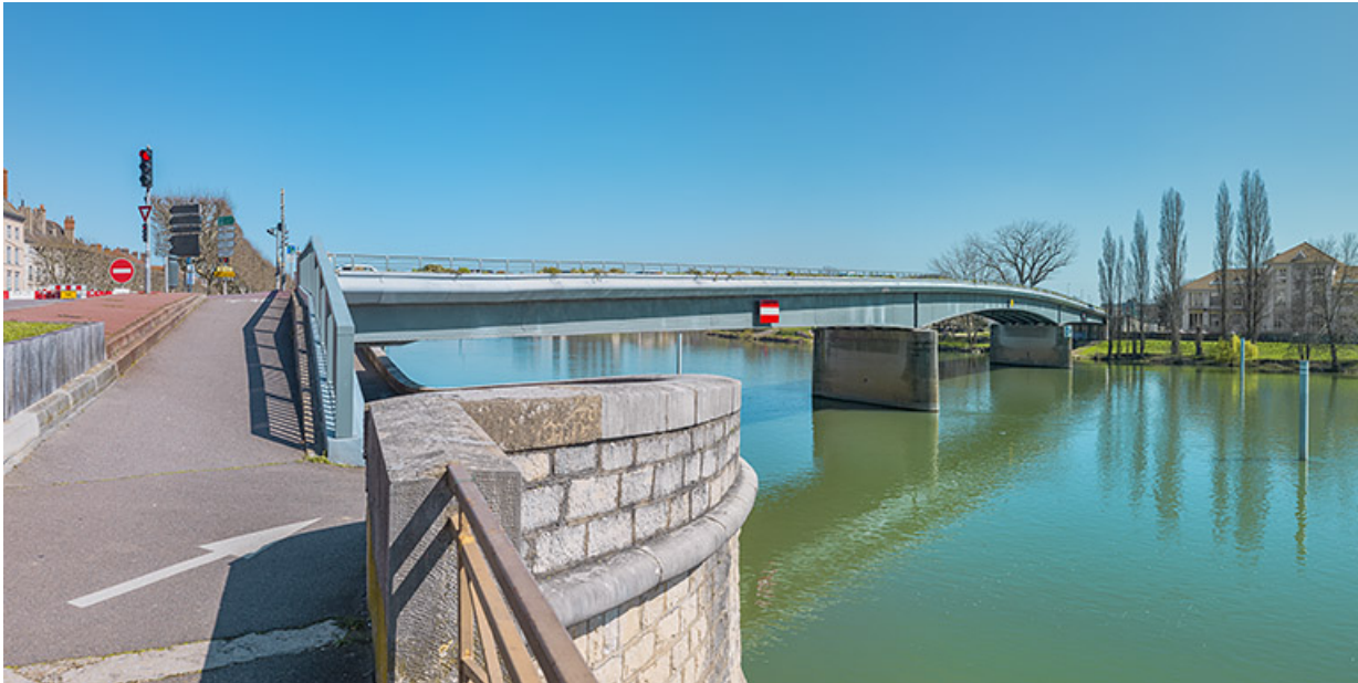
Vue d'ensemble du pont, prise d'aval. Au premier plan : la banquette de halage. 71, Chalon-sur-Saône route nationale 73, lieudit : PK 141.2
