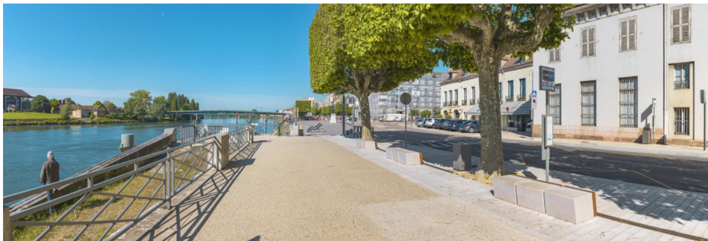
La place de Port-Villiers vue d'amont, depuis le quai des Messageries.
