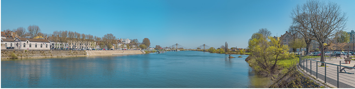
Vue d'ensemble, depuis la rive gauche, du quai Sainte-Marie et du ponton de Manon. 71, Chalon-sur-Saône quai Sainte-Marie
