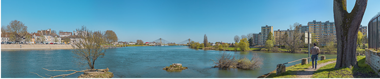
Depuis la pointe de l'île Saint-Laurent, de gauche à droite : le quai Sainte-Marie, le pont de Bourgogne et le bras de la Génise. 71, Chalon-sur-Saône quai Sainte-Marie
