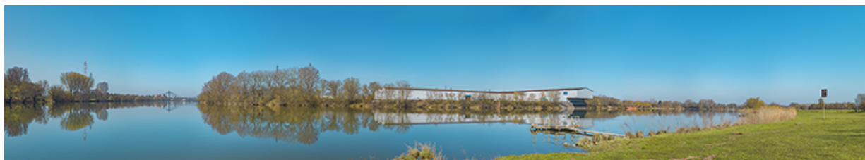
Vue panoramique de la Saône depuis l'entrée de la darse : en face, le port nord et au fond, le pont de Bourgogne. 71, Châtenoy-en-Bresse
