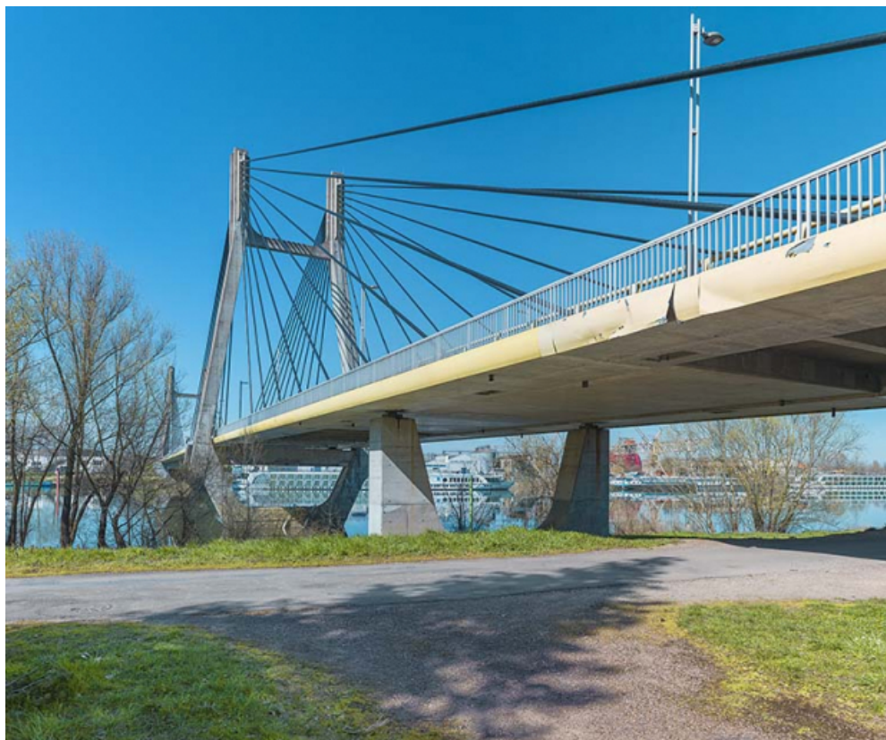
Vue rapprochée du pont, depuis la rive gauche.
