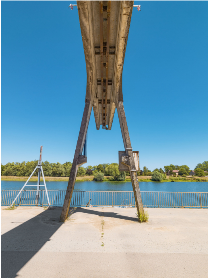
Portique de déchargement avec poulie.
