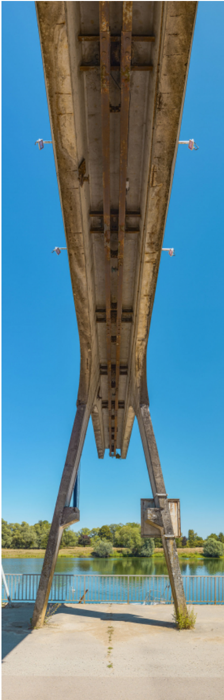
Portique de déchargement avec poulie.
