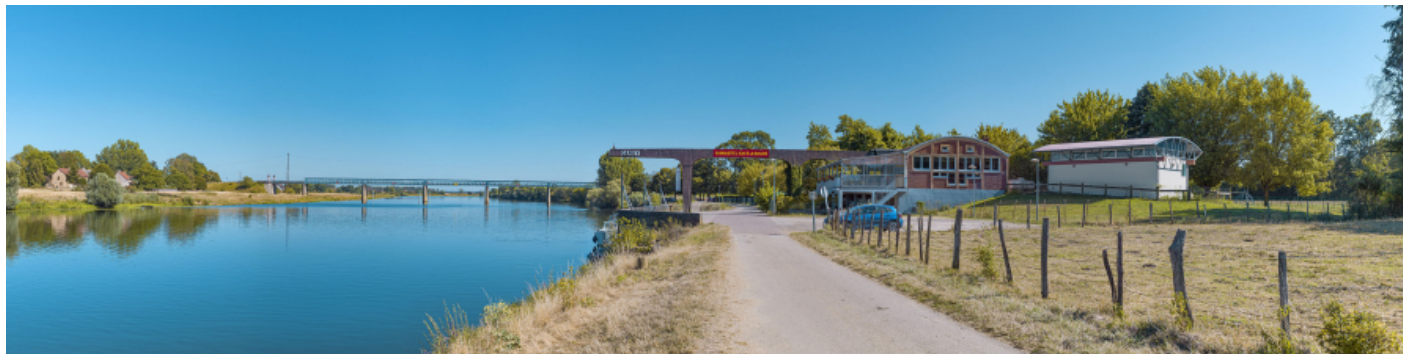
Le port de Gergy, vu d'amont. Le pont Boucicaut en arrière-plan.
