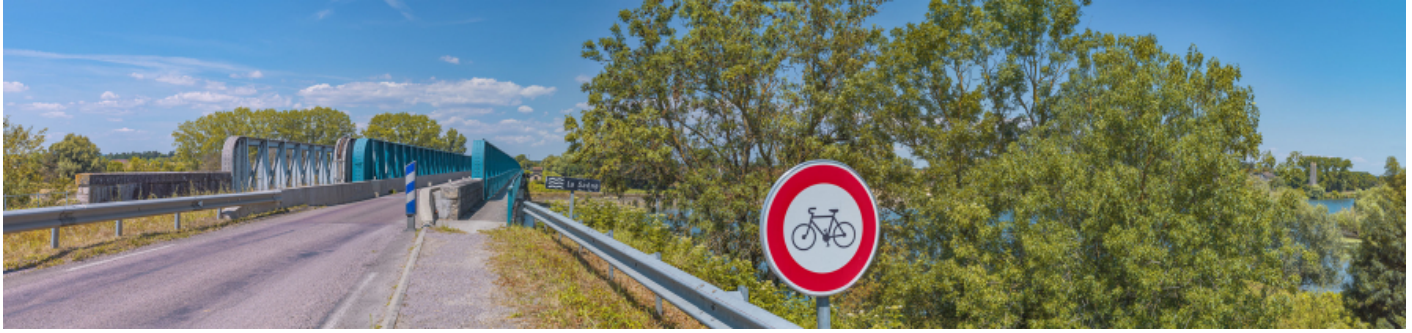
Le pont mixte de Chauvort : à gauche, la voie ferrée désaffectée et à droite, la voie routière et piétonne. 71, Allerey-sur-Saône, lieudit : PK 164,5 Chauvort
