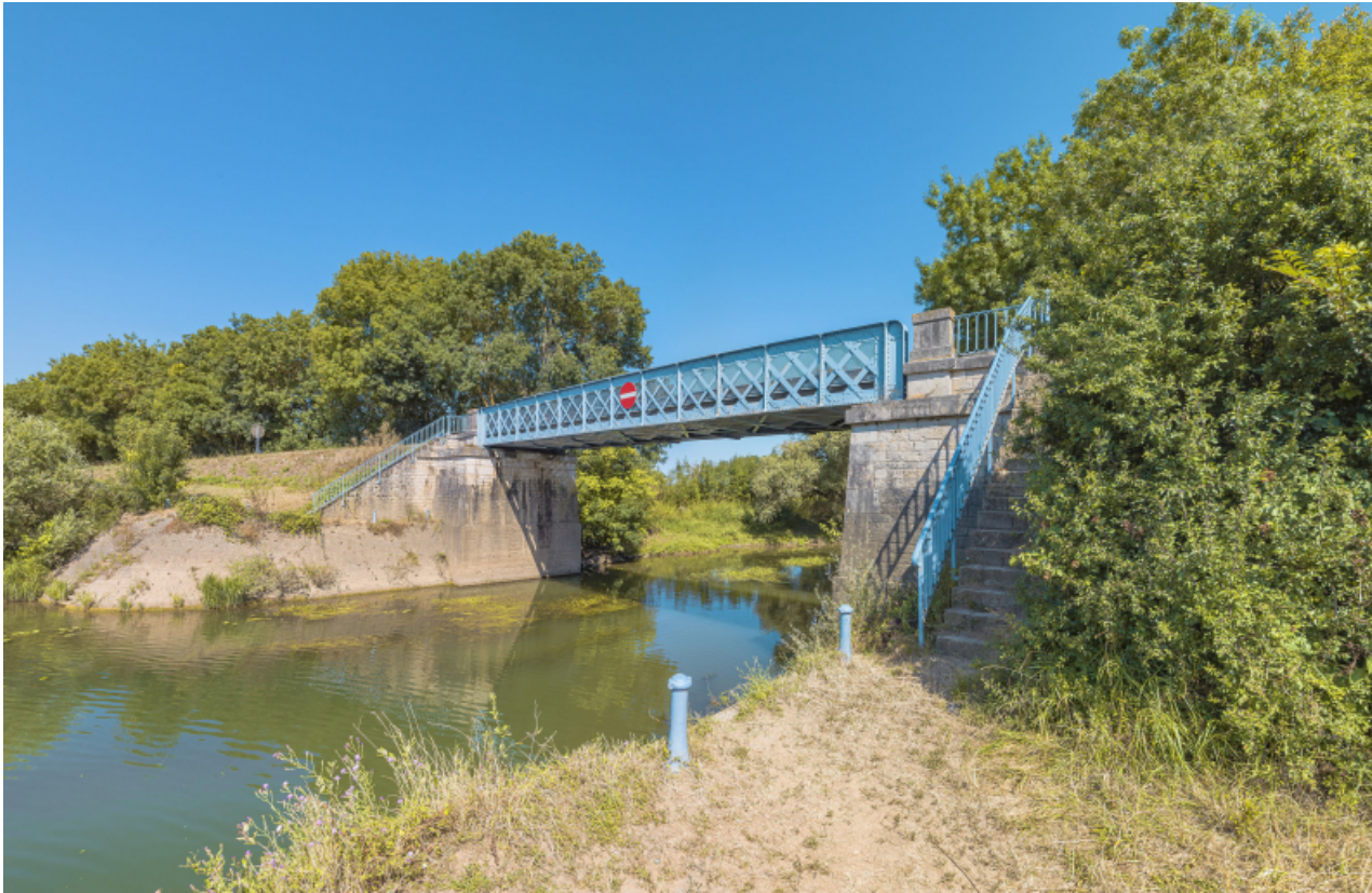
Le pont sur la Dheune, vu d'amont.
