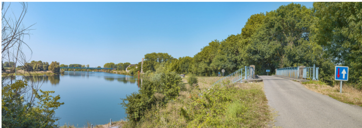
Le pont sur la Dheune, vu d'amont. En arrière-plan, la digue et le viaduc de Chauvort.
