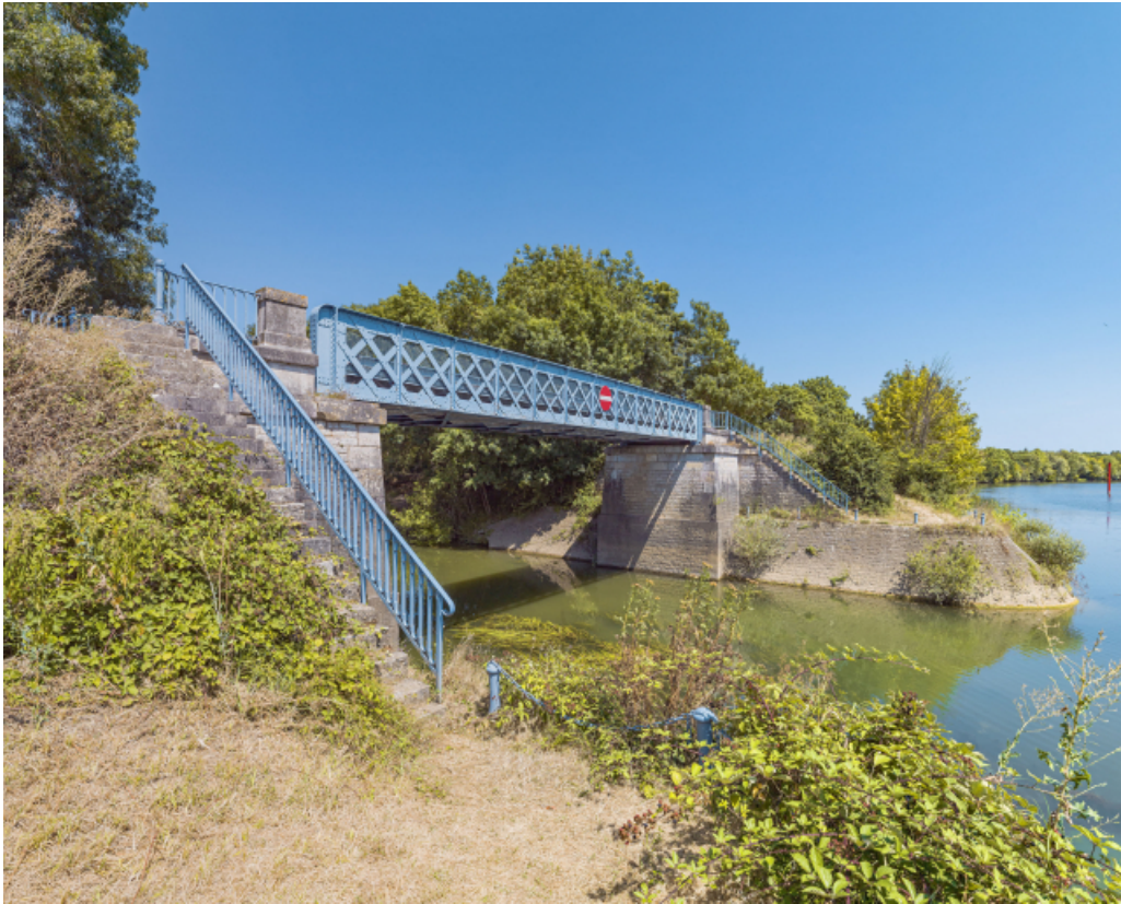
Vue d'ensemble du pont sur la Dheune.
