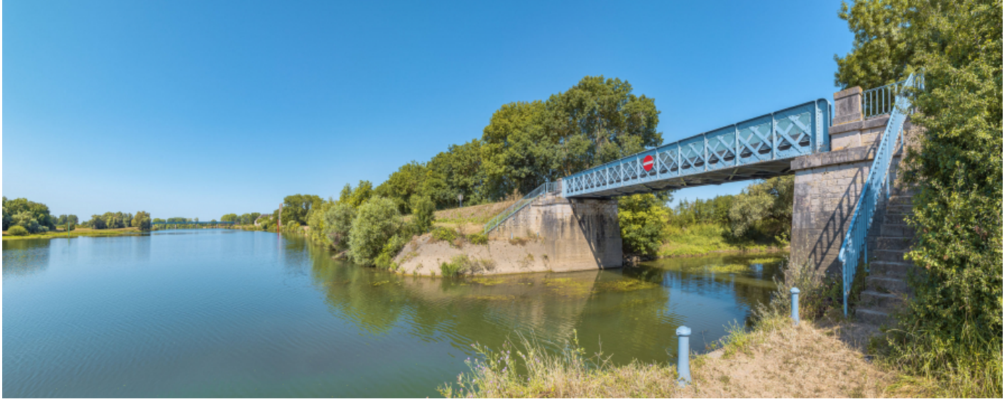
Le pont sur la Dheune, vu d'amont. En arrière-plan, la digue et le viaduc de Chauvort. 71, Bragny-sur-Saône, lieudit : PK 165,3
