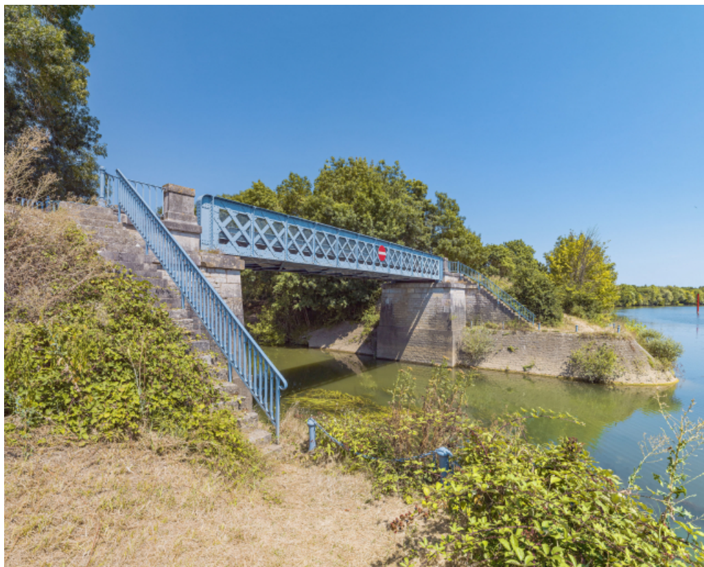
Vue d'ensemble du pont sur la Dheune.
