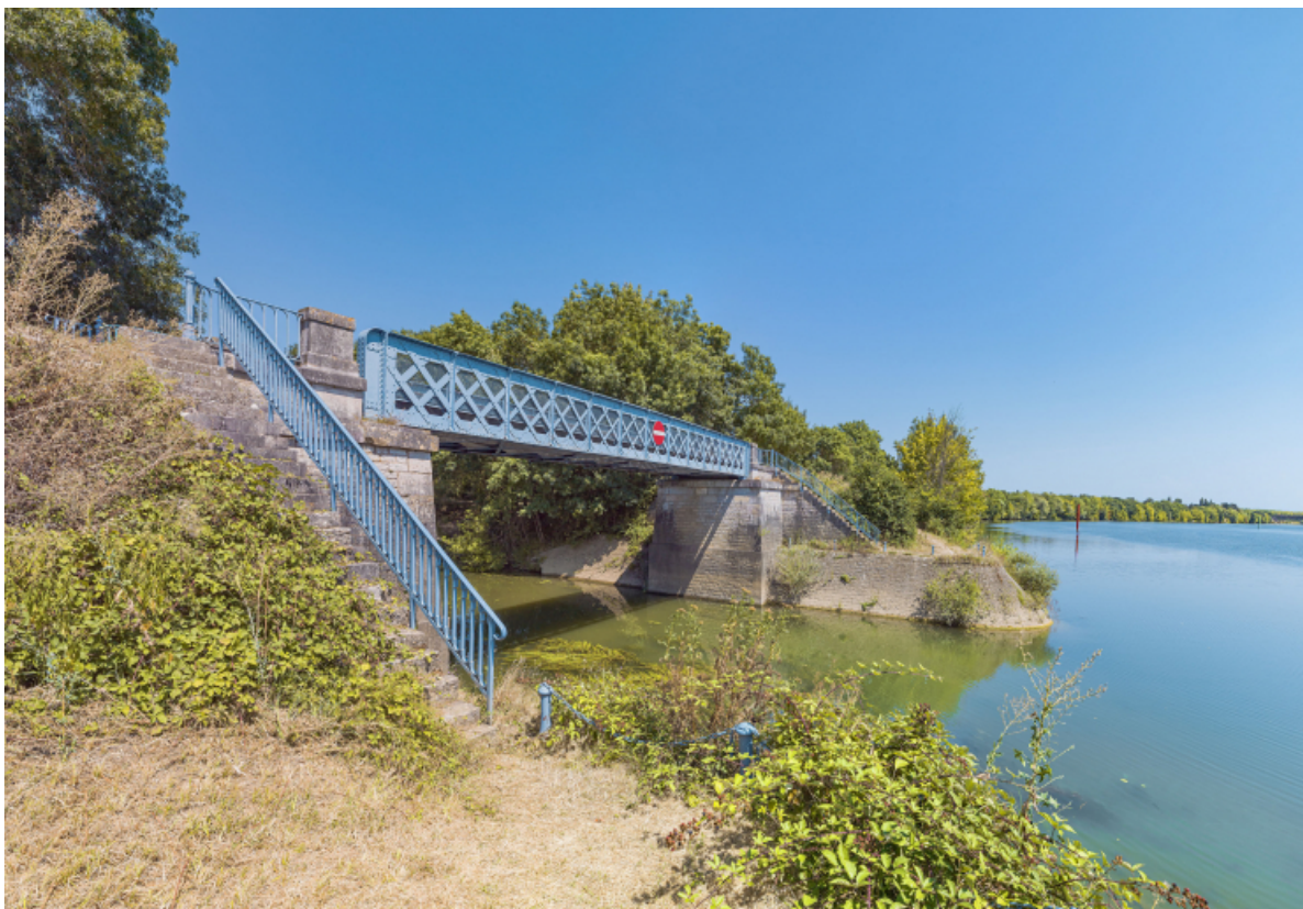
Vue d'ensemble du pont sur la Dheune.
