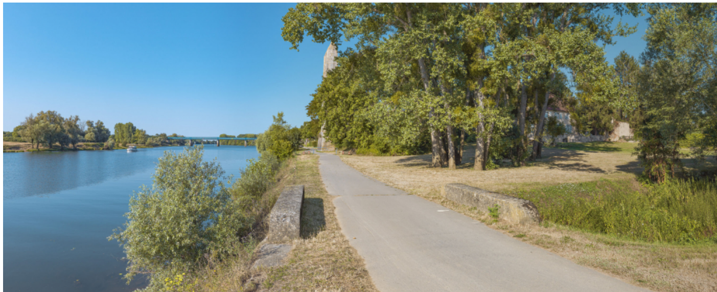
La digue de Chauvort, vue d'amont.
