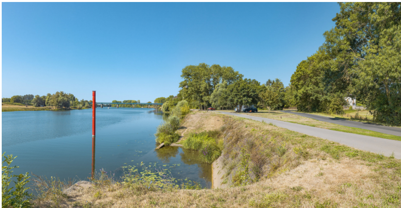
La digue de Chauvort depuis la rampe d'abreuvoir en amont.
