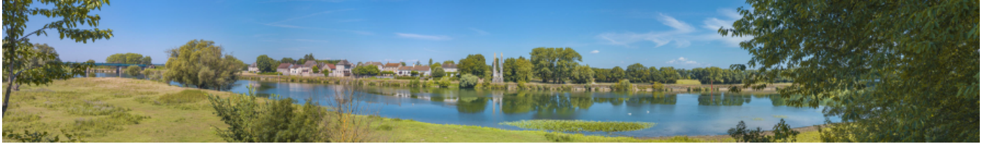
Vue d'ensemble du hameau de Chauvort et de la digue entre le pont sur la Dheune, en amont et le viaduc de Chauvort, en aval. 71, Allerey-sur-Saône, lieudit : Chauvort
