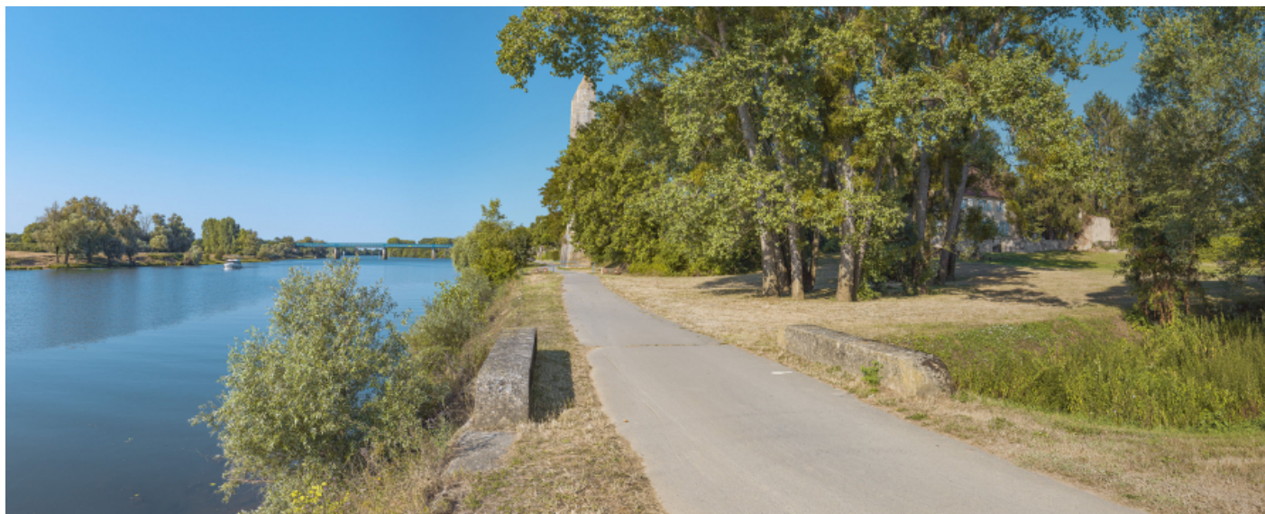
La digue de Chauvort, vue d'amont.
