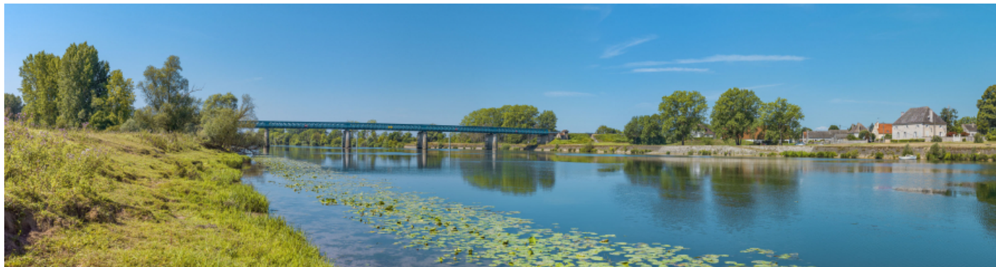
Vue d'ensemble du hameau de Chauvort et de la digue entre l'ancien pont suspendu et le viaduc.
