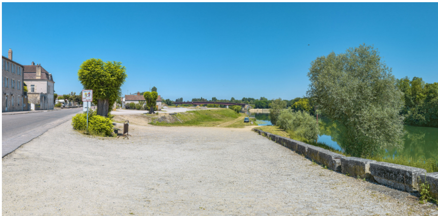
Le port de Verdun : rampe d'accès et escaliers de service.
