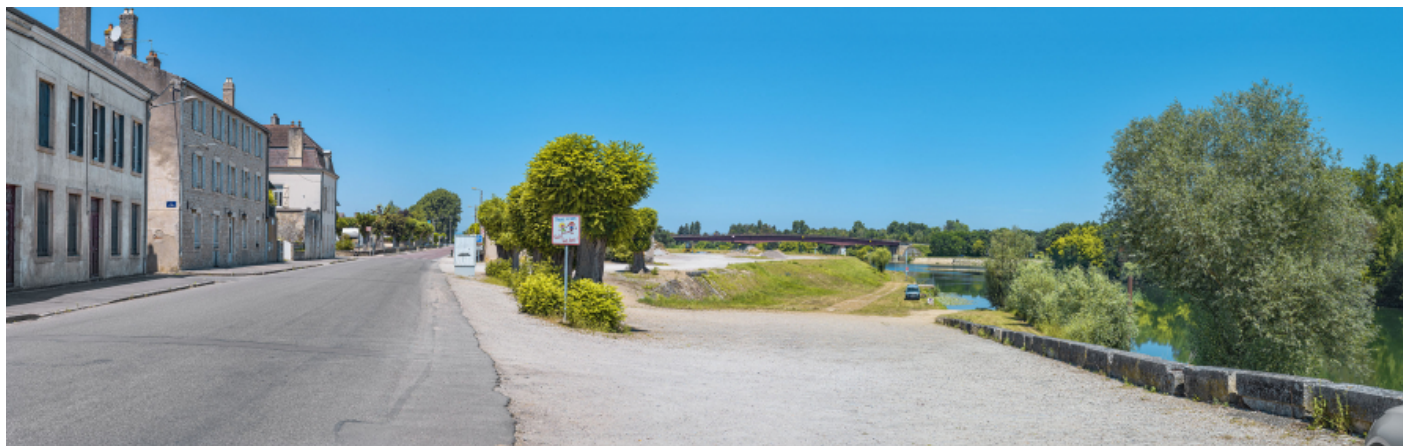
Le port de Verdun : rampe d'accès et escaliers de service.
