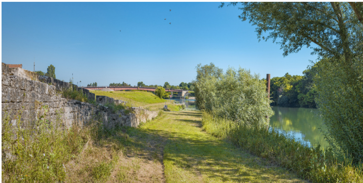
Quais et port de Verdun. Le pont de Bragny en arrière-plan.
