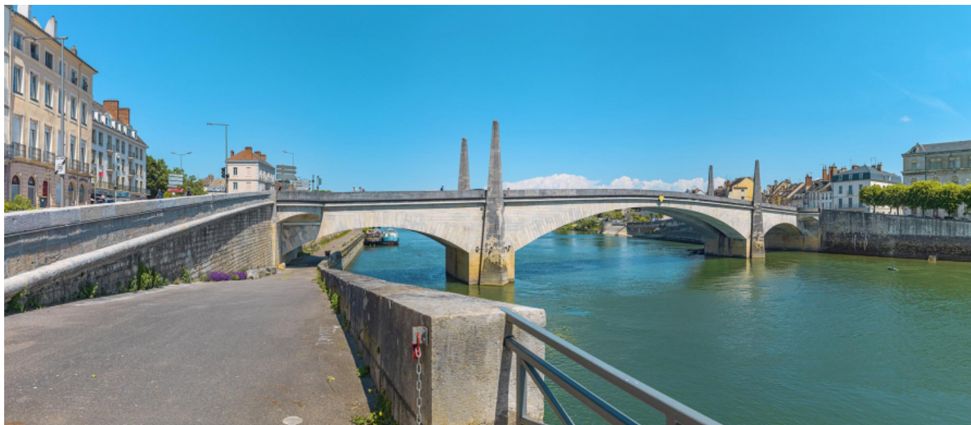
Vue d'ensemble du pont, depuis la banquette de halage aval. 71, Chalon-sur-Saône route départementale 19, lieu-dit : PK 141.83
