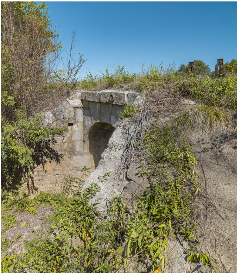
Vue d'ensemble du ponceau et des vannes, rive gauche.
