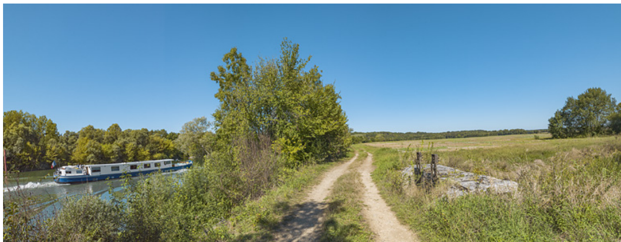
Le chemin de halage au niveau du ponceau : à droite le système de vannes sur la Raie du Grand Meix, à gauche, la Saône. 71, Charnay-lès-Chalon, lieudit : PK 171.5
