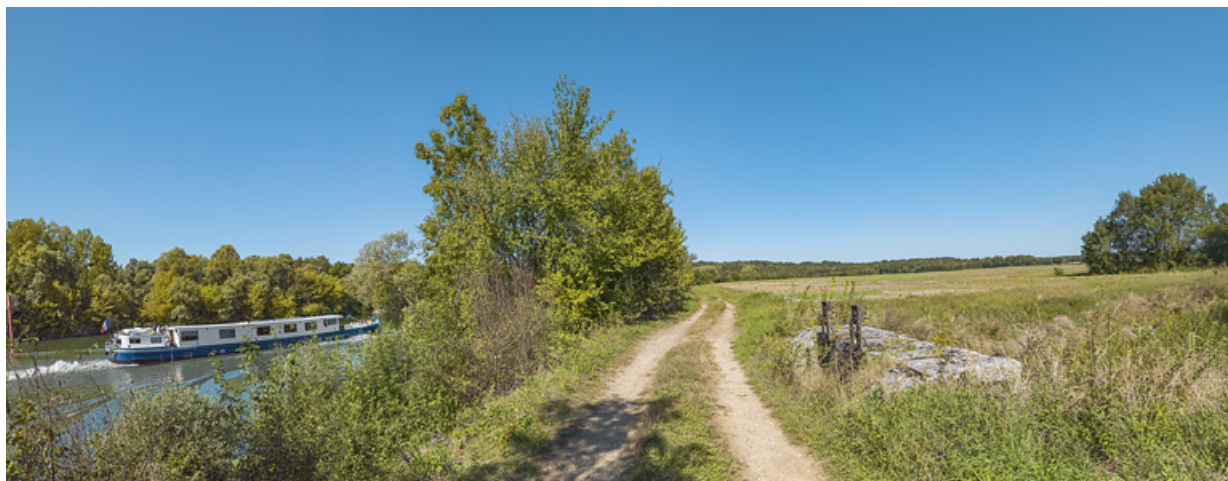
Le chemin de halage au niveau du ponceau : à droite le système de vannes sur la Raie du Grand Meix, à gauche, la Saône. 71, Charnay-lès-Chalon, lieudit : PK 171.5
