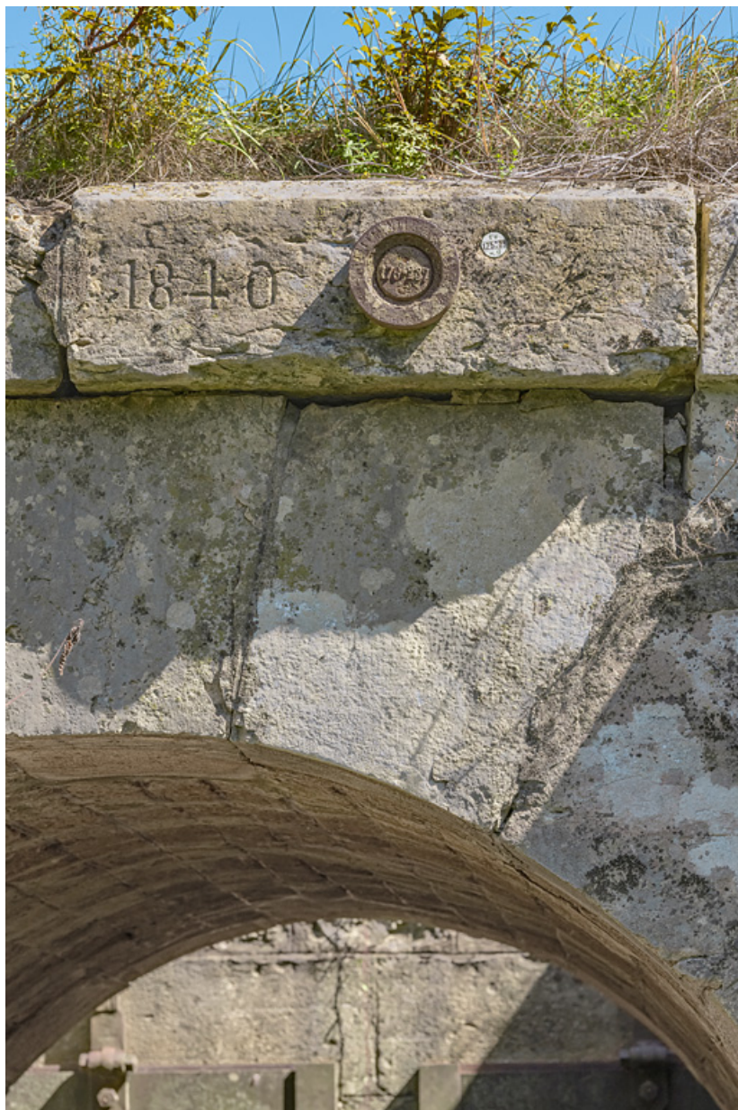
La date de 1840 gravée sur le pont, côté Saône.
