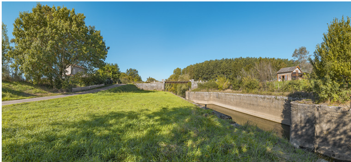
Vue d'ensemble du site de l'écluse de Charnay : à gauche, la maison éclésièrè, au centre, le pont sur écluse et à droite, la remise. 71, Charnay-lès-Chalon, lieudit : PK 176
