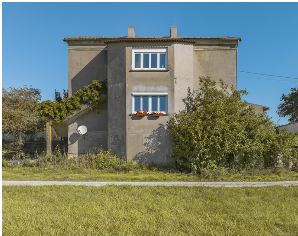
Façade arrière avec l'ajout d'un avant-corps central.
