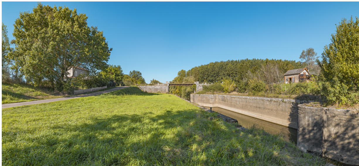
Vue d'ensemble du site de l'écluse de Charnay : à gauche, la maison éclésièrè, au centre, le pont sur écluse et à droite, la remise. 71, Charnay-lès-Chalon, lieudit : PK 176
