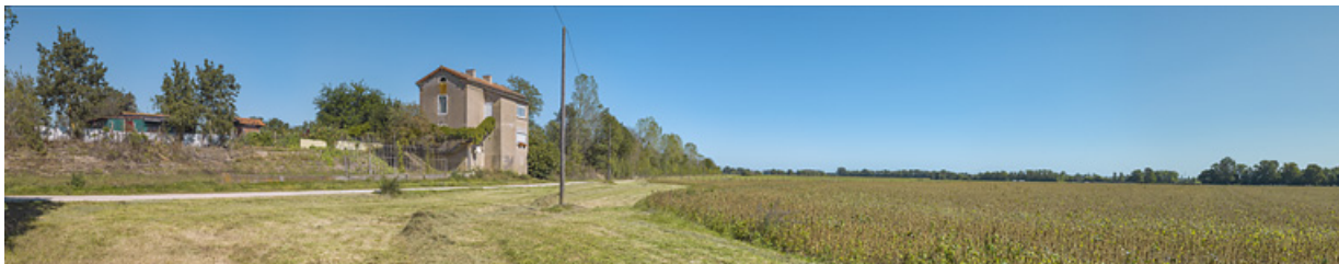
La maison éclusière, vue d'aval, dans son environnement paysager.
