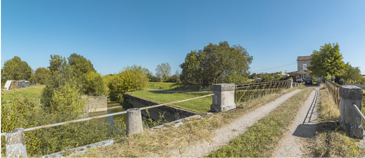
Le site d'écluse vu depuis la rive gauche, au niveau du pont sur écluse.
