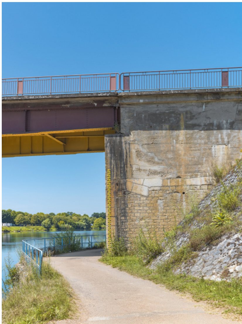
Culée rive droite du pont de Bragny. On lit les différentes phases de reconstruction de l'ouvrage. 71, Verdun-sur-le-Doubs route départementale 111, lieudit : PK 166,6
