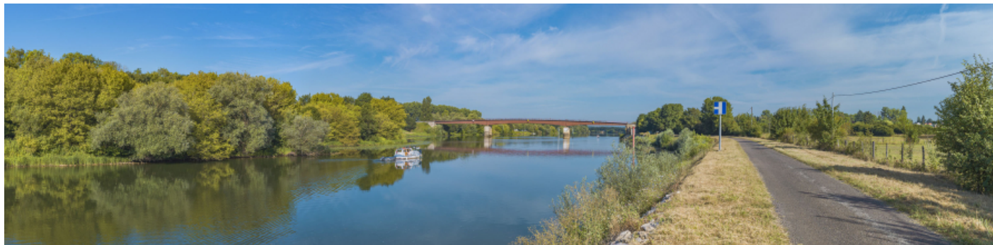
Le pont de Bragny vu d'amont depuis la rive droite.
