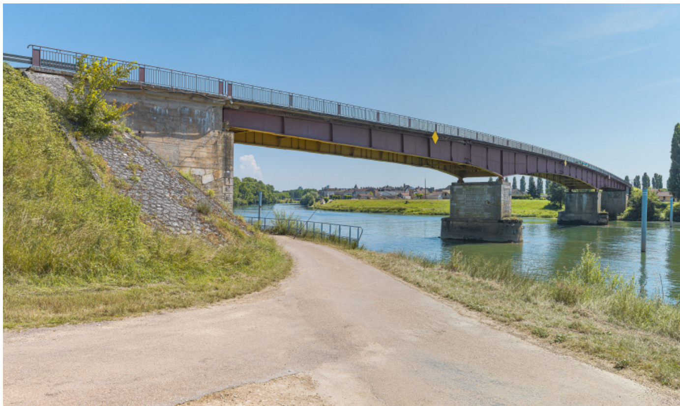
Le pont de Bragny, vu d'aval. La ville de Verdun-sur-le-Doubs en arrière-plan.
