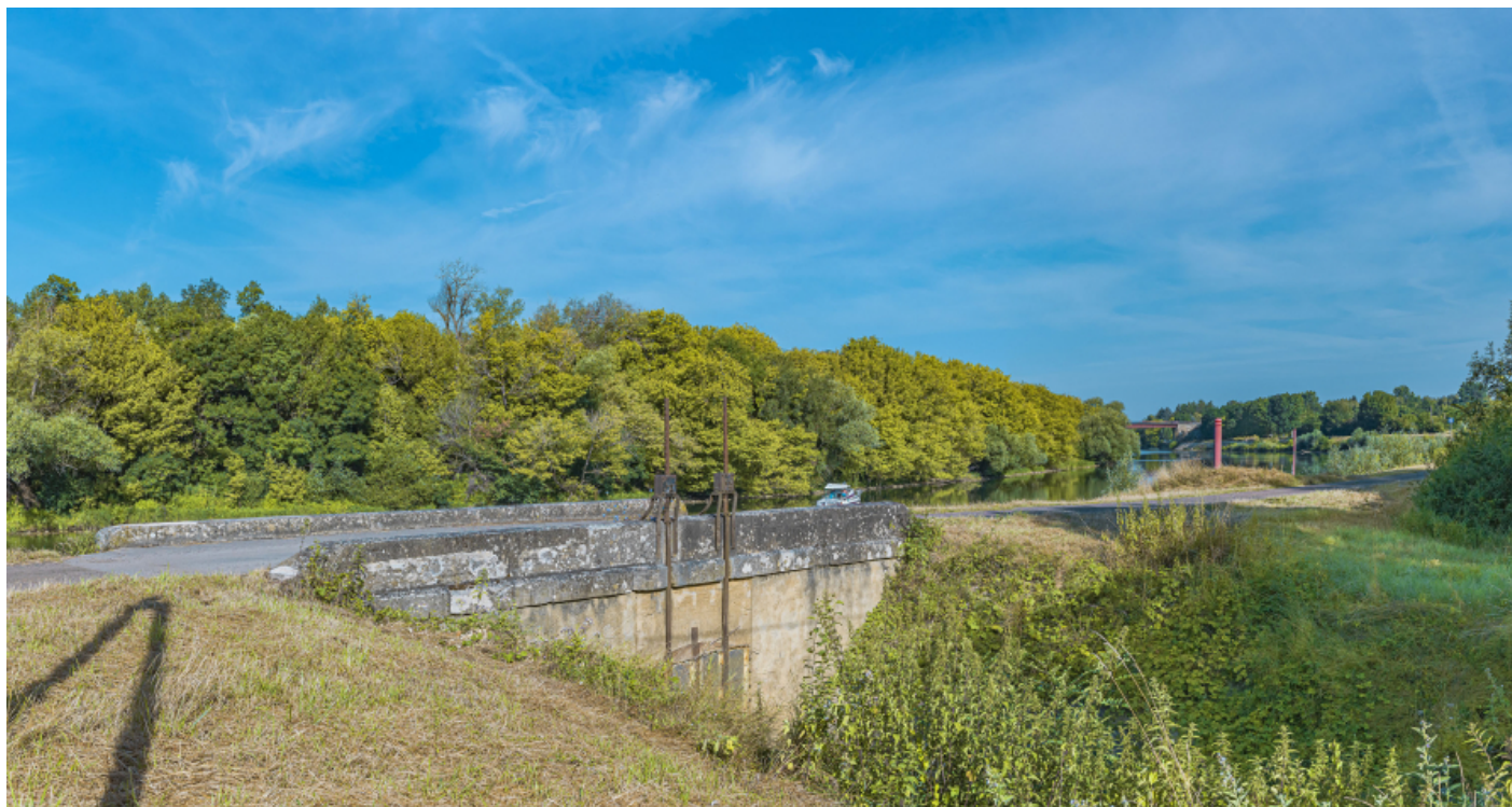
Vue d'ensemble du ponceau avec le système de vannes. On distingue le pont de Bragny en arrière-plan. 71, Bragny-sur-Saône, lieudit : PK 167
