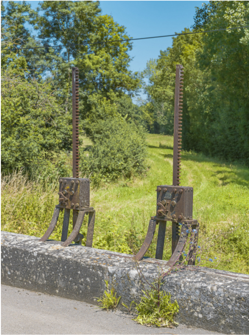
Détail des deux vannes du ponceau.
