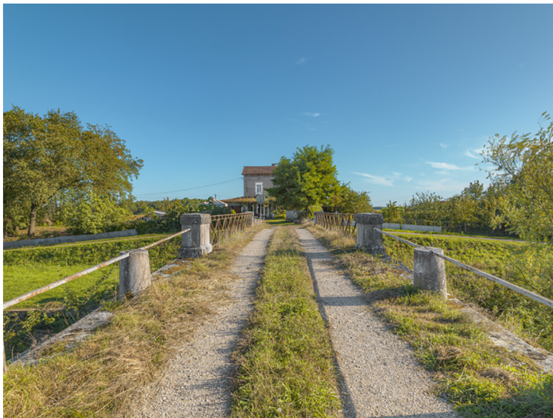
Vue d'ensemble du pont sur l'écluse depuis la rive droite. En face, la maison éclusière.
