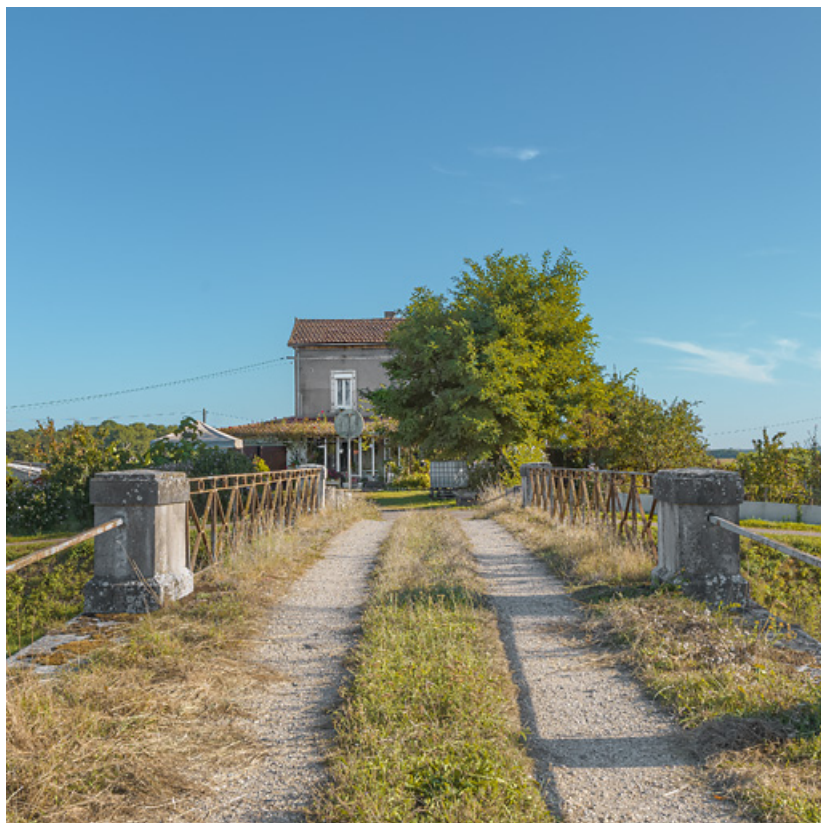
Vue d'ensemble du pont sur l'écluse depuis la rive droite. En face, la maison éclusière. 71, Charnay-lès-Chalon, lieudit : PK 176
