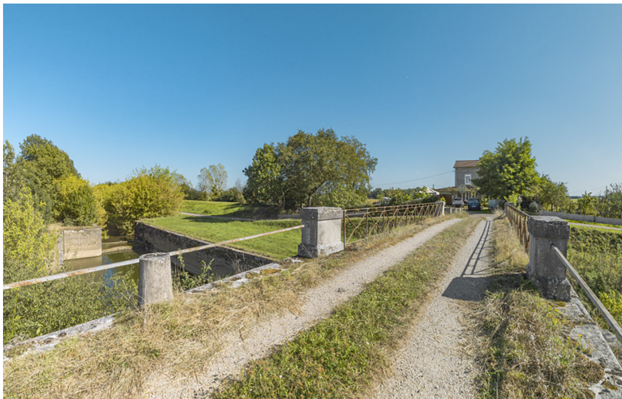
Vue d'ensemble du pont sur l'écluse depuis la rive droite. En face, la maison éclusière.
