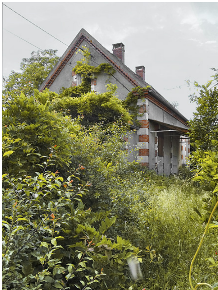
Vue d'ensemble de la maison en 2019, avant destruction.
