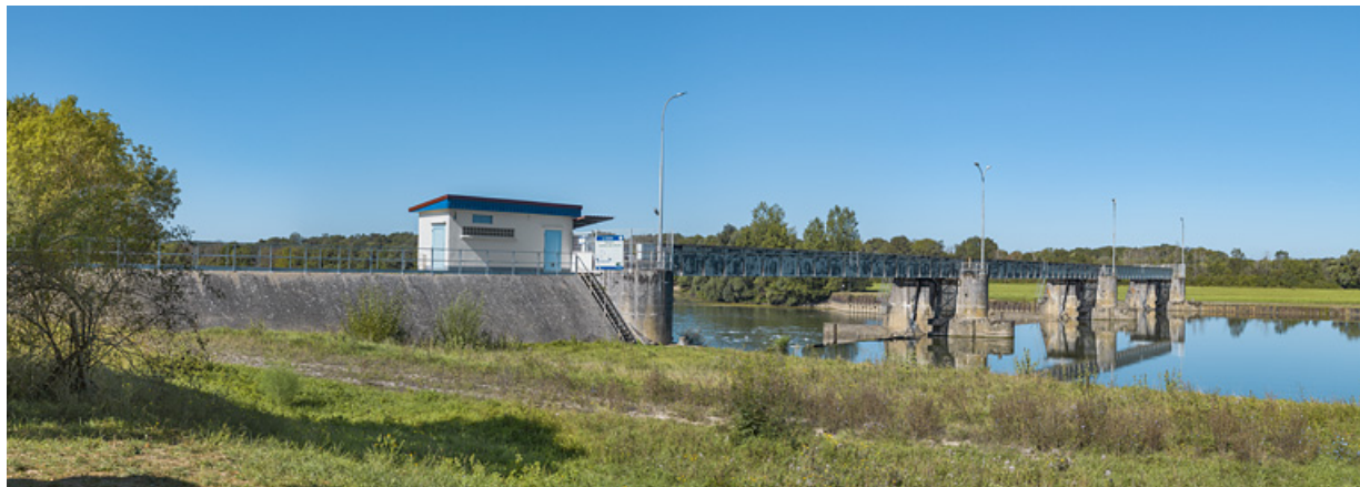
Vue d'ensemble d'amont depuis Charnay-lès-Chalon, rive gauche.
