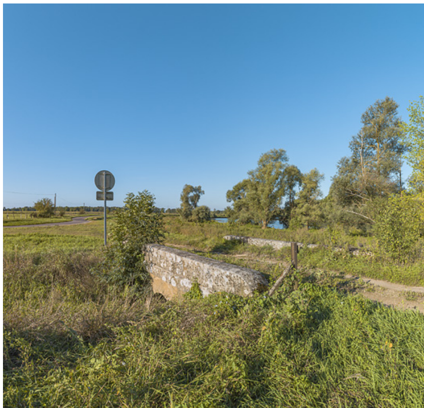
Chemin de halage et ponceau, le long du bief de Charnay sur le chemin de l'ancienne écluse. 71, Charnay-lès-Chalon
