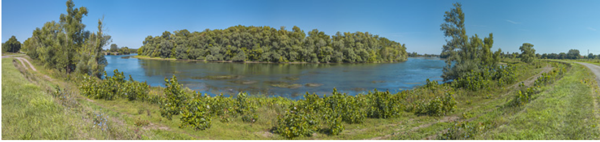
Vue d'ensemble de la partie de bief comprise entre les deux barrages de Charnay. A gauche, l'ancien et à droite, le nouveau. 71, Charnay-lès-Chalon
